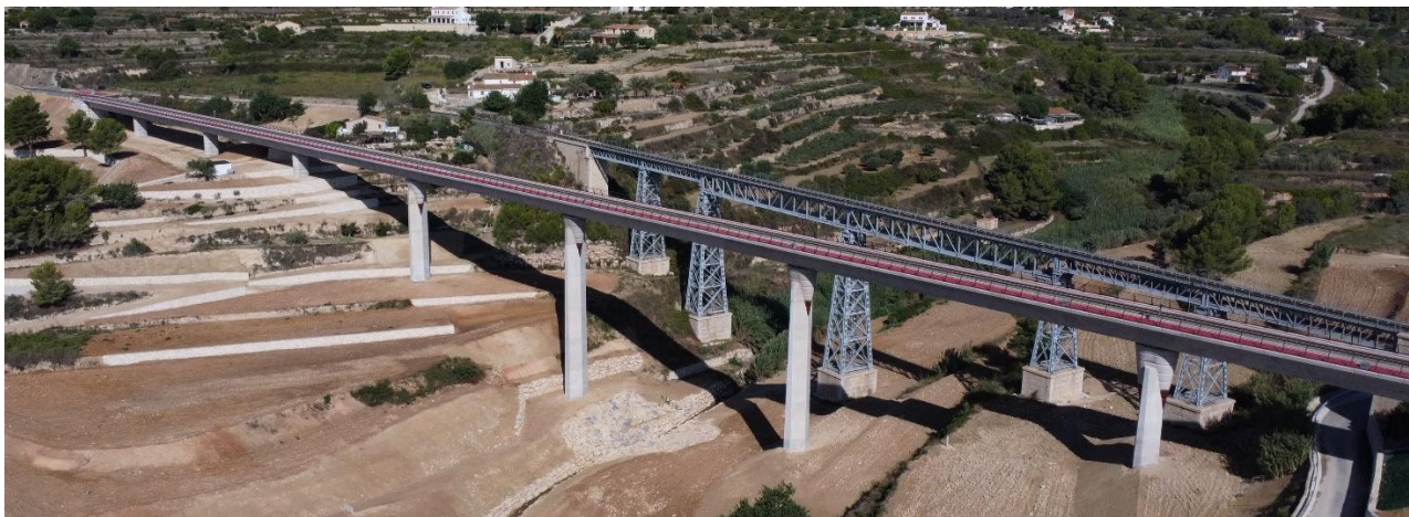
Figura 1. Viaductos nuevo y antiguo
