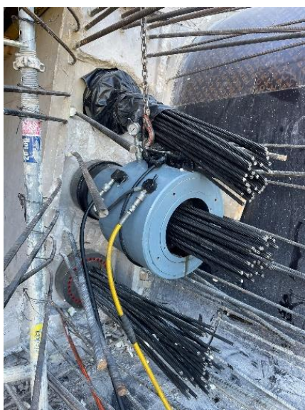
Figura 16. Tesado de armadura activa
