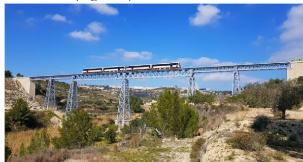
Figura 2. Prueba de carga del viaducto de Santa Ana existente
