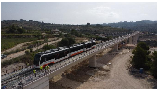
Figura 15. Ejecución de la prueba de carga
