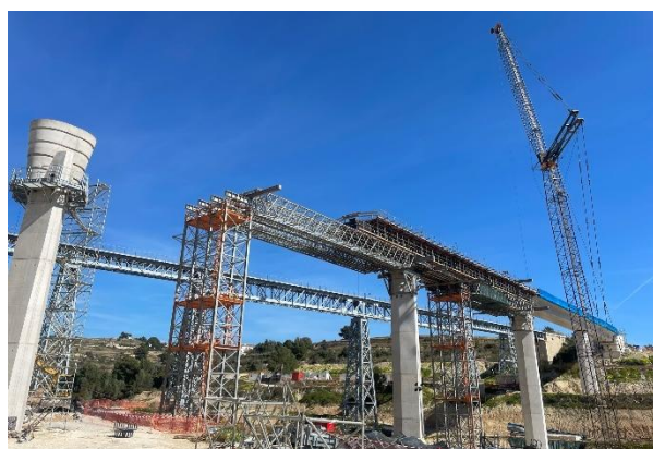
Figura 10. Imagen de la ejecución del tablero en la zona del barranco
