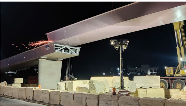
Figura 17. Montaje de la estructura metálica durante un corte nocturno
