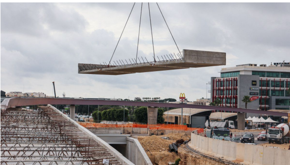
Figura 18. Montaje de las prelasas sobre el tablero
