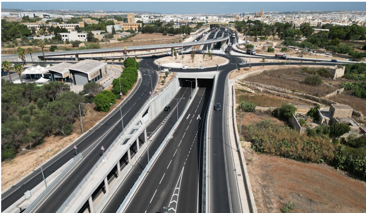
Figura 1. Vista aérea del nudo WA24 finalizado
