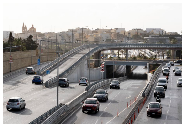
Figura 10. Paso inferior S.S.12 y paso superior S.S.7
