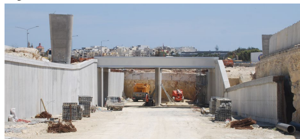
Figura 14. Muros prefabricados, muros in-situ y paso inferior
