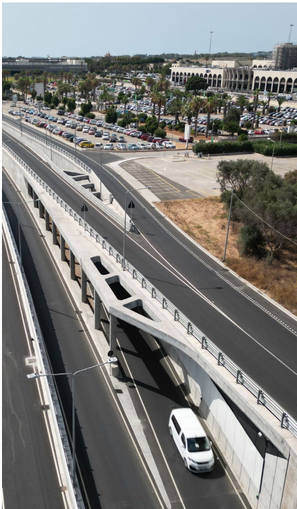
Figura 3. Vista general de la pérgola.
