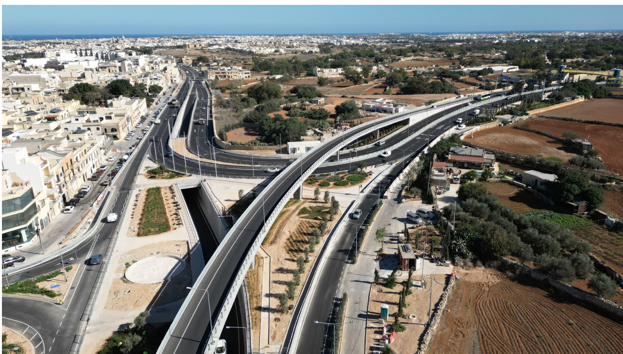
Figura 2. Vista aérea del nudo WA23 finalizado
