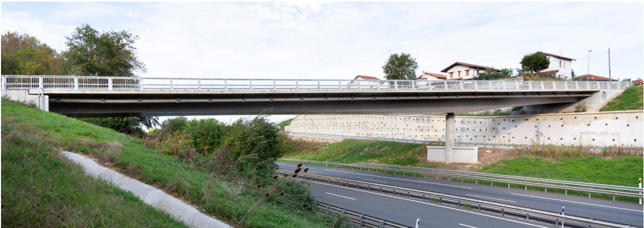
Figura 11. Vista lateral del PS-2
