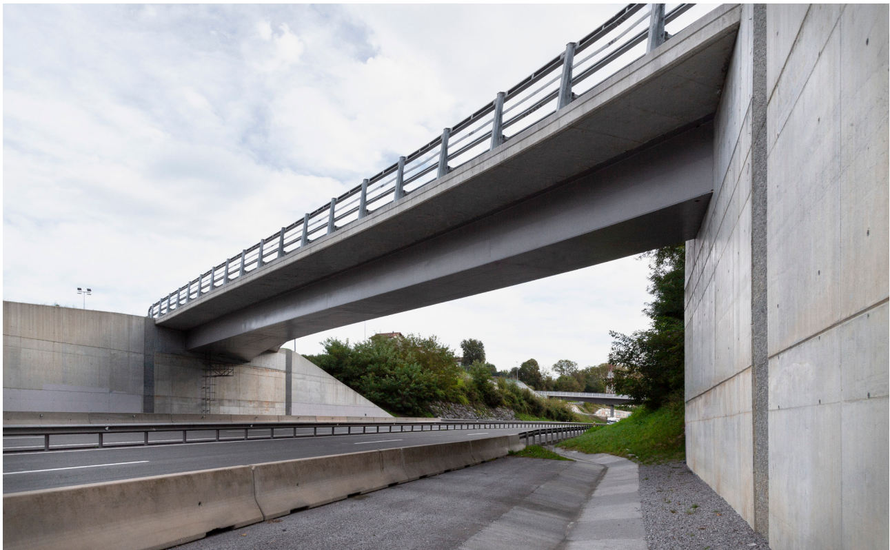
Figura 7. Vista lateral del PS-1 y estribo integral
