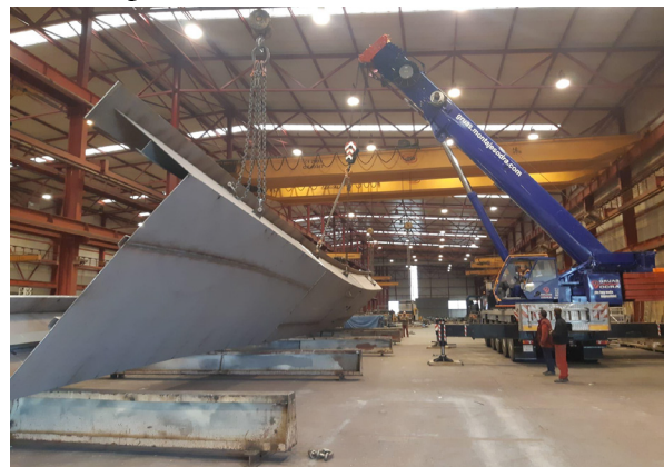
Figura 22. Volteo del cajón metálico en taller en el que se aprecia un empalme longitudinal en la platatabanda inferior
