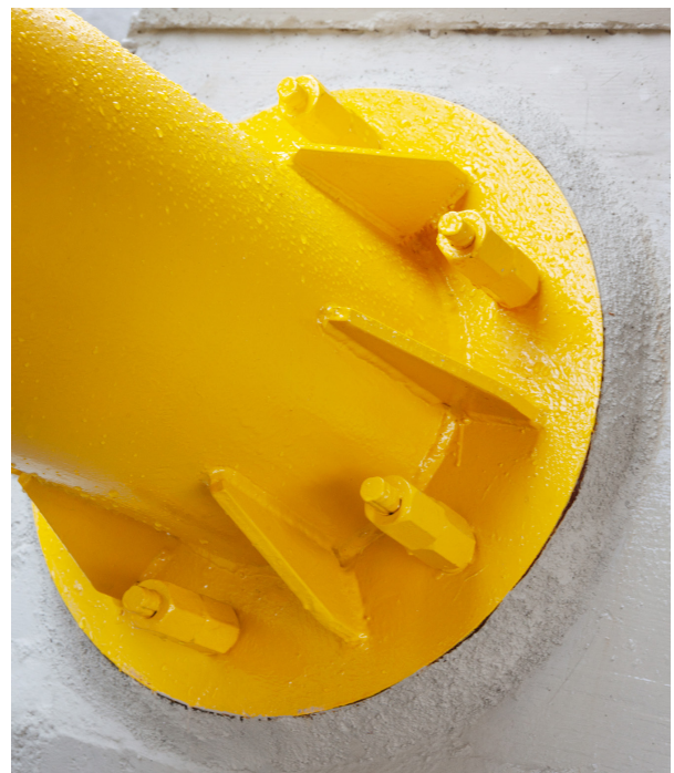
Figura 13. Placa de anclaje del arco
