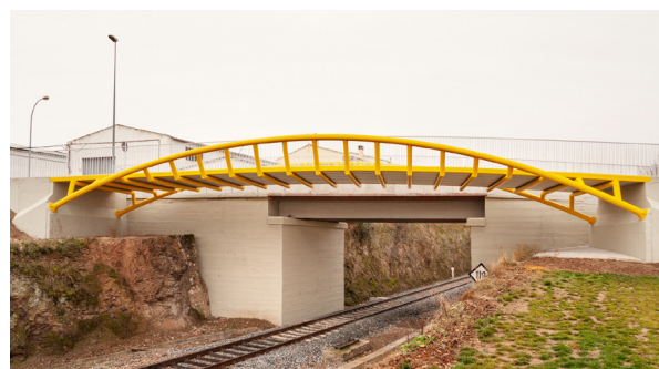
Figura 3. Vista de la pasarela y del paso superior
