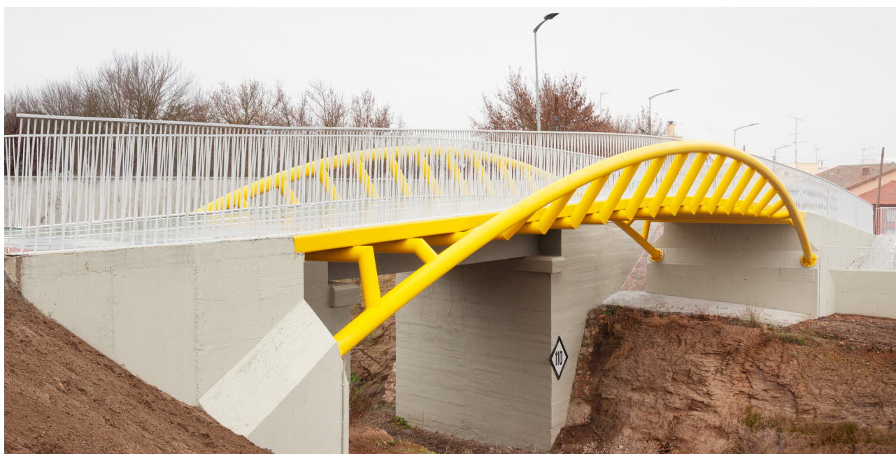
Figura 7. Vista general de la pasarela
