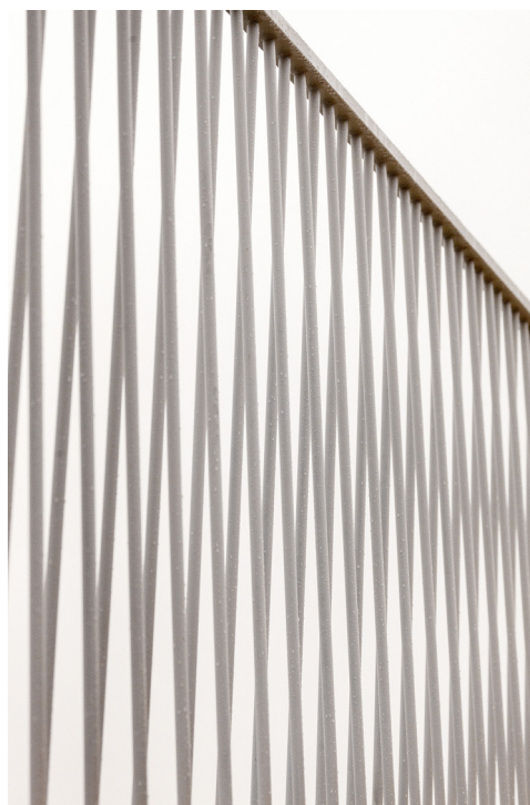
Figura 10. Detalle de barandilla
