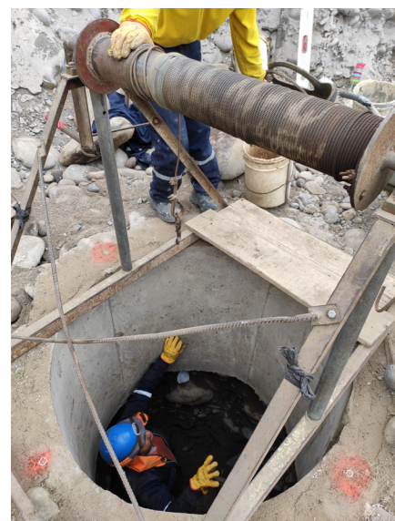
Figura 15. Vista general de la excavación manual de los pilotes del estribo de la margen derecha
