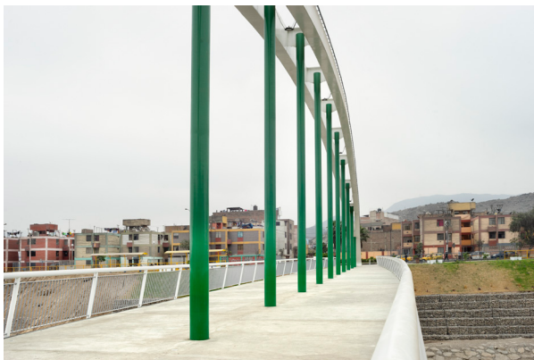
Figura 3. Vista interior de la pasarela
