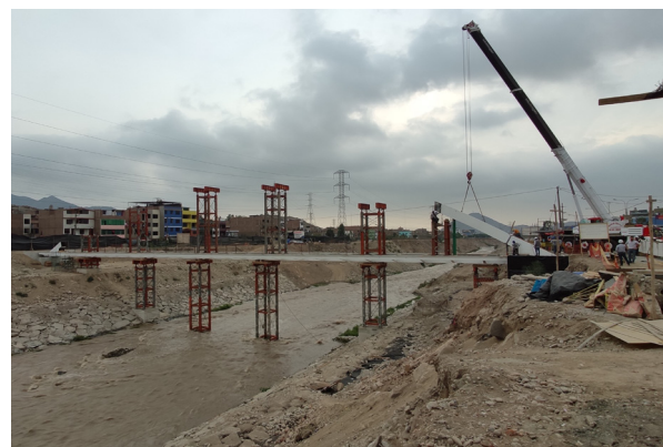
Figura 18. Maniobra de montaje del arco sobre torres de apeo provisionales
