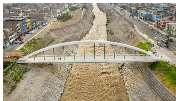
Figura 4. Vista lateral de la pasarela
