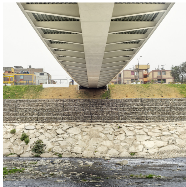
Figura 8. Muro de gaviones y escollera de pie de talud
