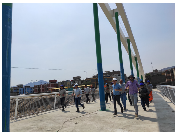
Figura 19. Excitación de la estructura por el paso de un grupo de personas corriendo
