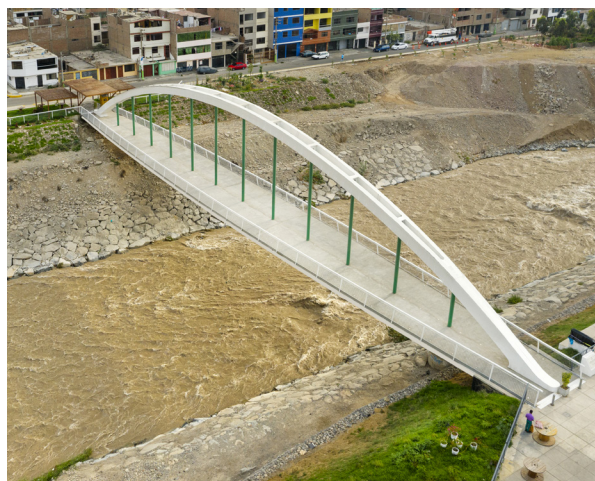
Figura 1. Vista general de la pasarela
