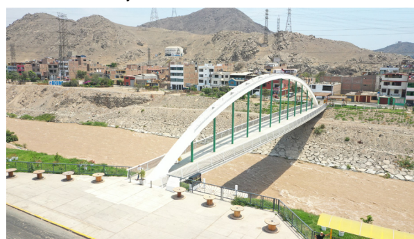
Figura 20. Nueva plataforma de desembarco de la pasarela en la margen derecha
