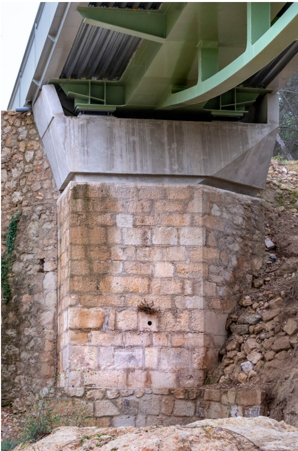
Figura 8. Estribo 1 de la pasarela
