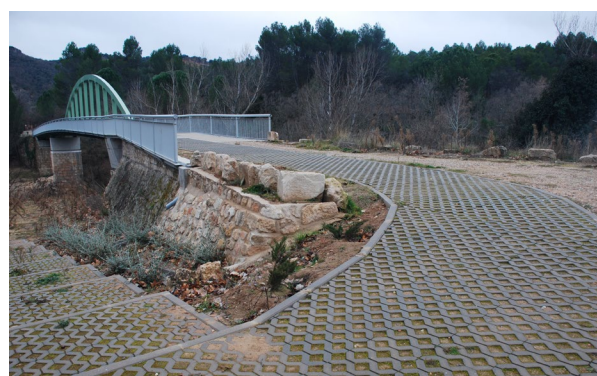
Figura 18. Detalle del pavimento de la rampa italiana
