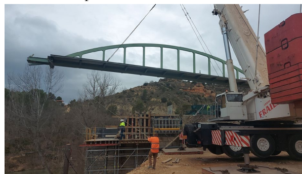
Figura 15. Montaje del vano principal
