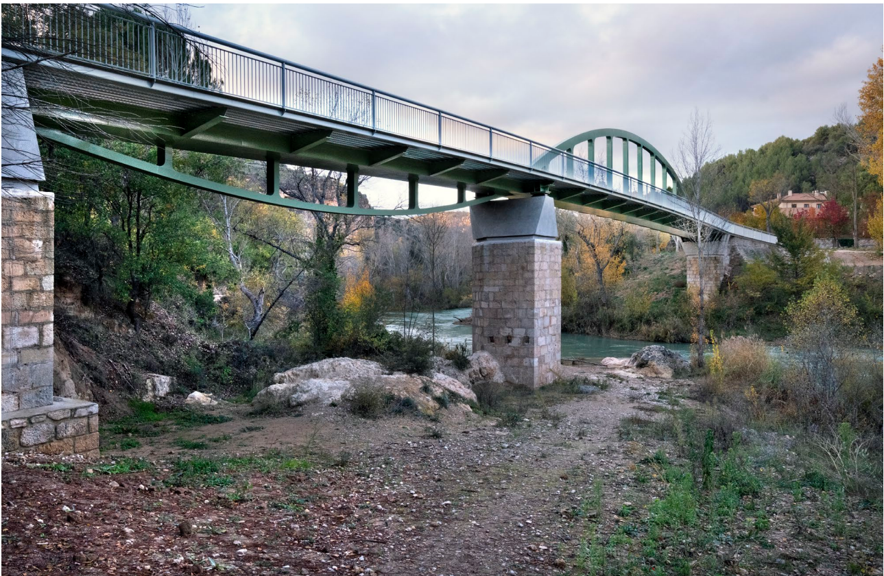
Figura 7. Vista inferior de la pasarela
