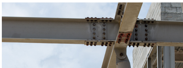
Figura 22. Unión atornillada.
