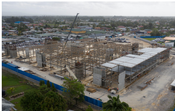
Figura 5. Vista general del edificio durante la ejecución
