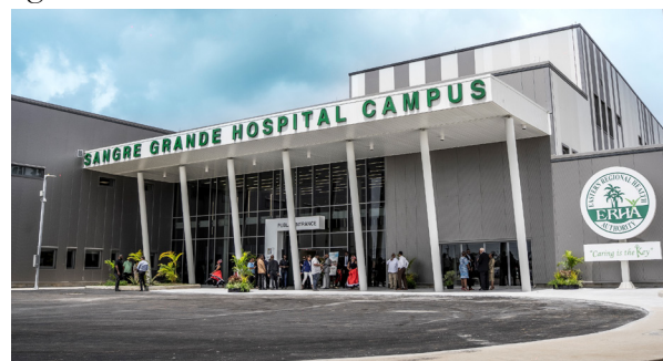
Figura 3. Marquesina de acceso principal
