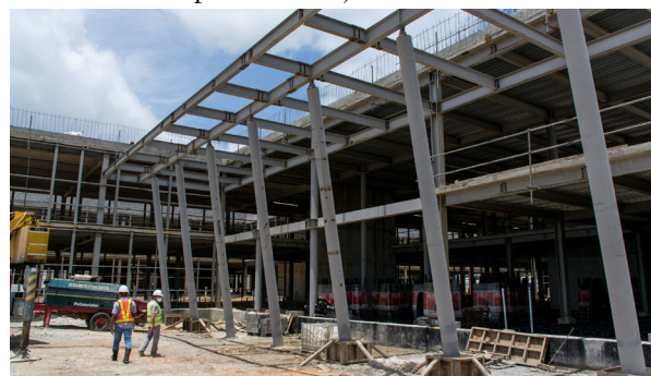
Figura 21. Marquesina de acceso durante la ejecución, con uniones atornilladas.
