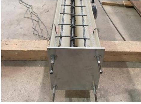
Figura 6. Placa acero 6mm en extremo de viga.
