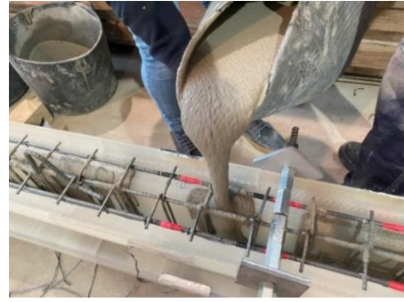
Figura 7. Vertido del hormigón en el interior de la viga.
