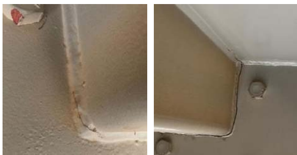
Figura 24. Fisura inicial
