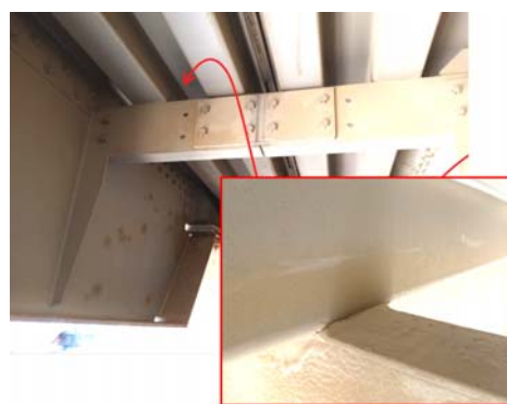
Figura 27. Soldadura entre nervio y travesaño
