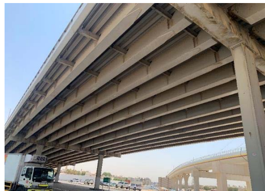
Figura 17. Vista general del puente
