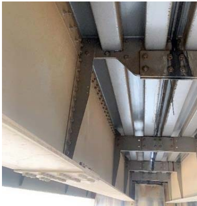
Figura 18. Vista del ensamble de las vigas transversales
