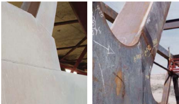
Figura 8. Nudo de la celosía estudiada, no diseñado a fatiga y ejemplo de nudo sí diseñado a fatiga
