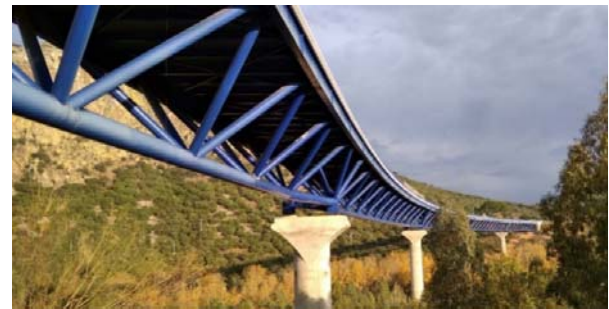
Figura 9. Vista general del puente
