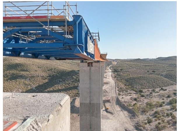
Figura 7. Nariz frontal de remonte.
