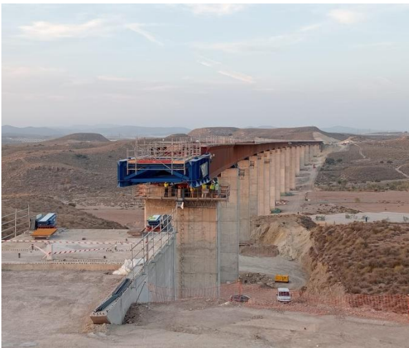
Figura 11. Vista general del Viaducto de Los Feos durante su lanzamiento.
