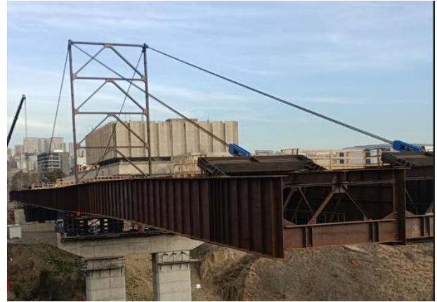
Figura 6. Torre de tirante provisional puente Bagebi.
