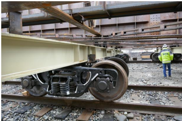
Figura 10. Bogies del parque de ensamblaje.
