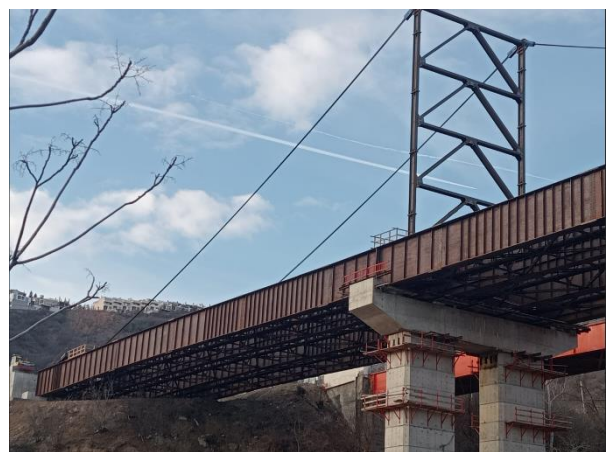
Figura 7. Tablero puente Bagebi durante el lanzamiento.
