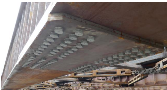
Figura 3. Conexión junta ala inferior.
