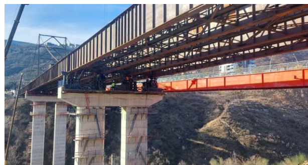
Figura 4. Tablero del puente Bagebi.
