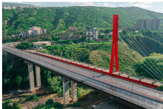
Figura 1. Puente de Bagebi finalizado.
