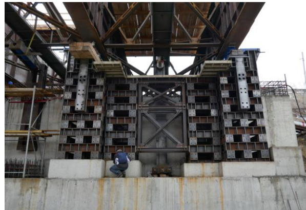
Figura 2. Torres provisionales estribo A1.
