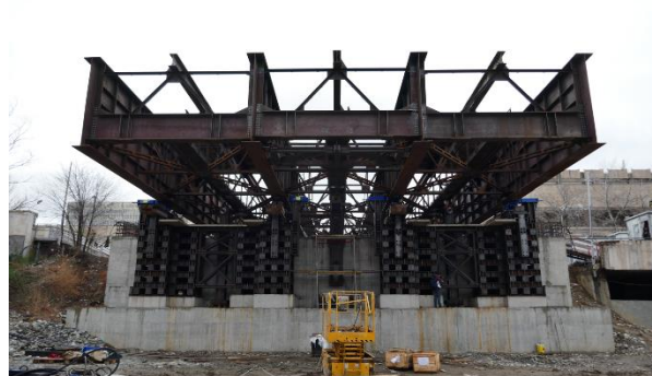
Figura 15. Vista Estribo A1 antes del lanzamiento.
