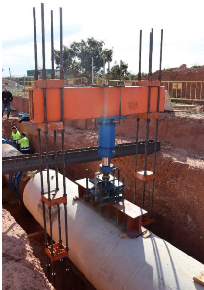
Figura 2. Montaje del pórtico de ensayo sobre RCCP.
