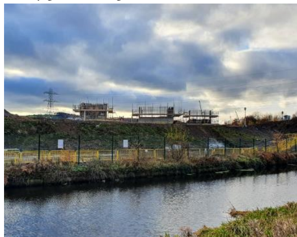
Figura 11. Trabajos de construcción del estribo Oeste.
