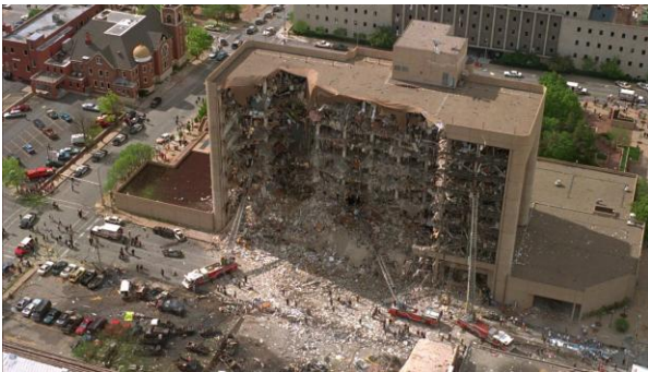
Figura 1. Ejemplo de colapso parcial de edificio: Edificio Federal Alfred P. Murrah, Oklahoma (EEUU) tras un ataque terrorista [2].
