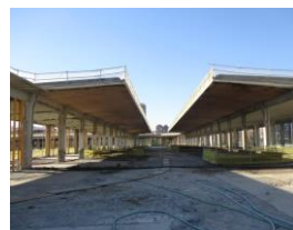
Figura 2. Vista de la planta superior
