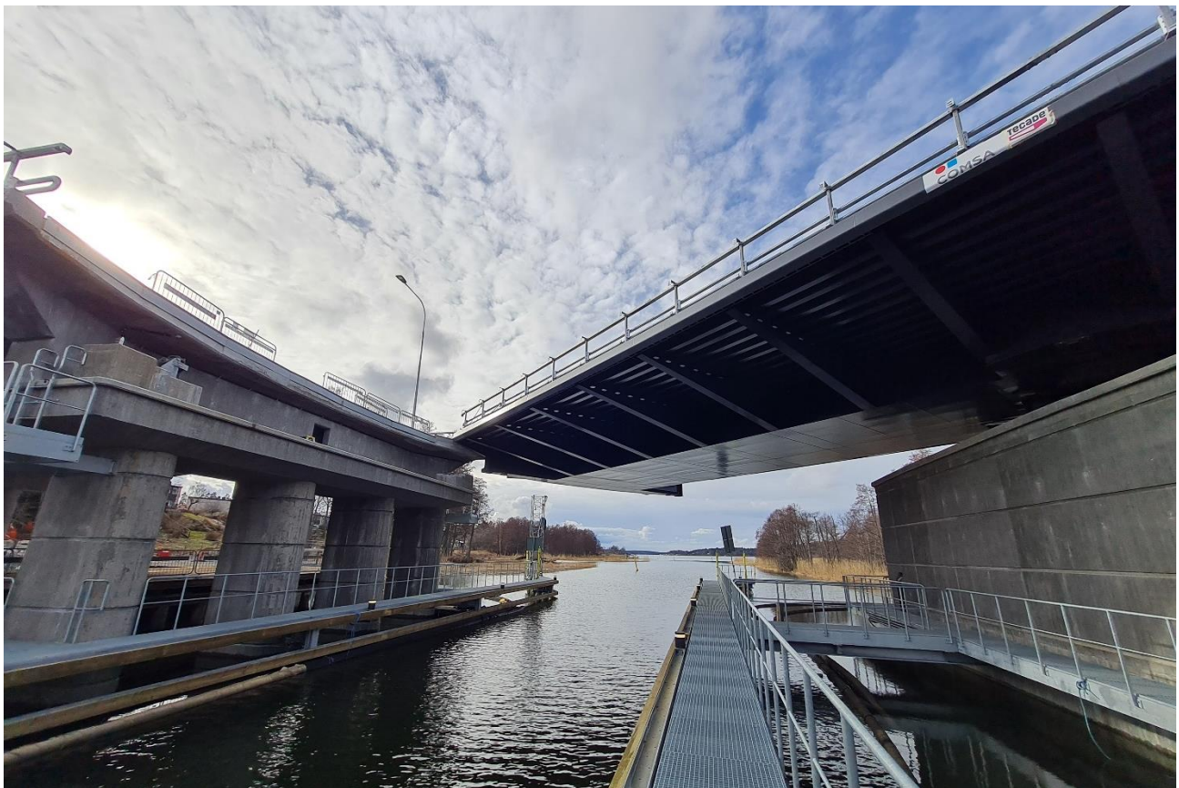
Figura 9. Vista desde la pasarela de mantenimiento en el lado de la pila-pivote.
