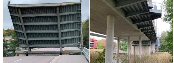
Figura 5. Puente basculante existente a reemplazar.
