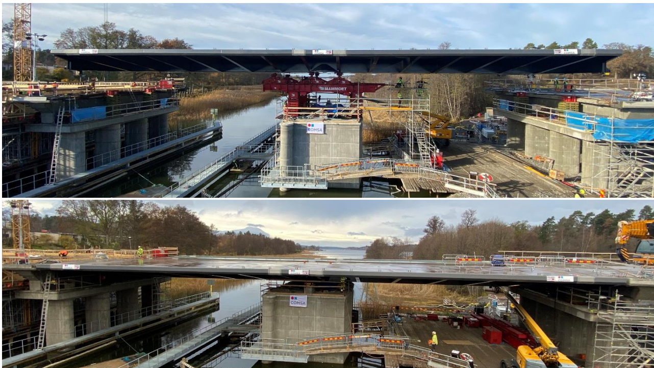
Figura 33. Fotografías previa y posterior al descenso final sobre apoyos definitivos
