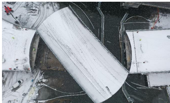
Figura 1. Vista en planta durante la apertura.
