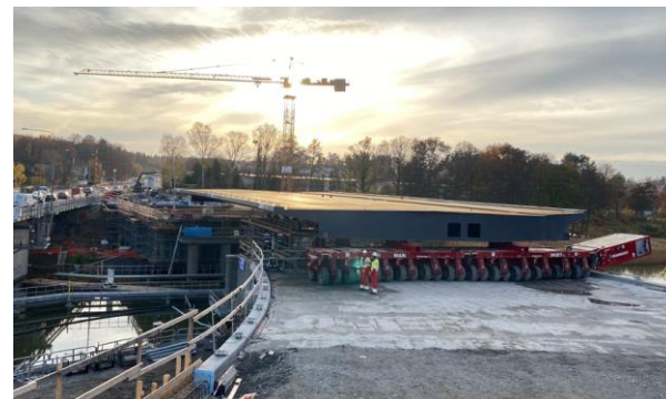
Figura 29. Carretones SPMT trasladando el tablero
