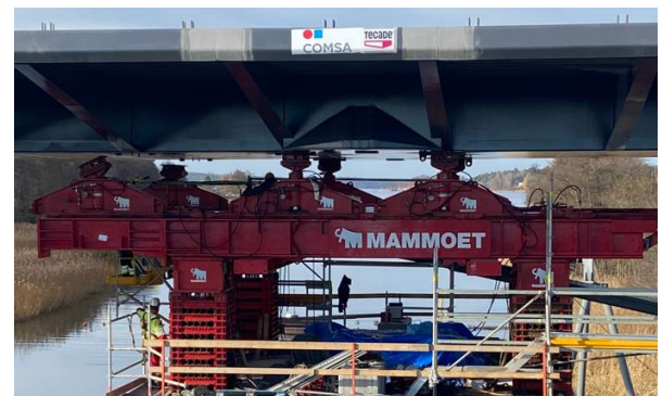
Figura 32. Detalle de la estructura de deslizamiento & gateo sobre la pila-pivote
