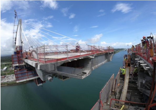
Figura 23. Avance en voladizo. Fuente: Panamá Atlántico.
