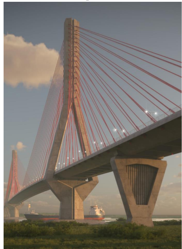
Figura 14. Infografía de pilonos y pila de retenida.
