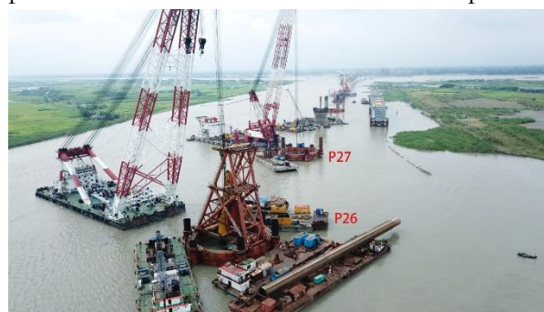
Figura 10. Ejecución de pilotes hincados. Fuente: Puente sobre el Padma. 2022.
