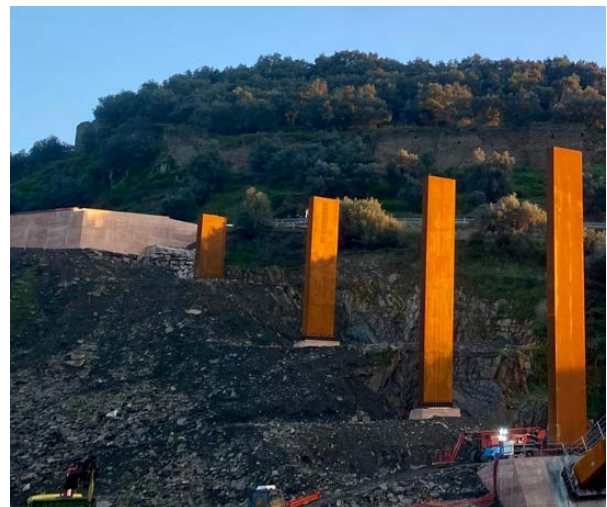
Figura 7 Aspecto de pilas y el estribo final
