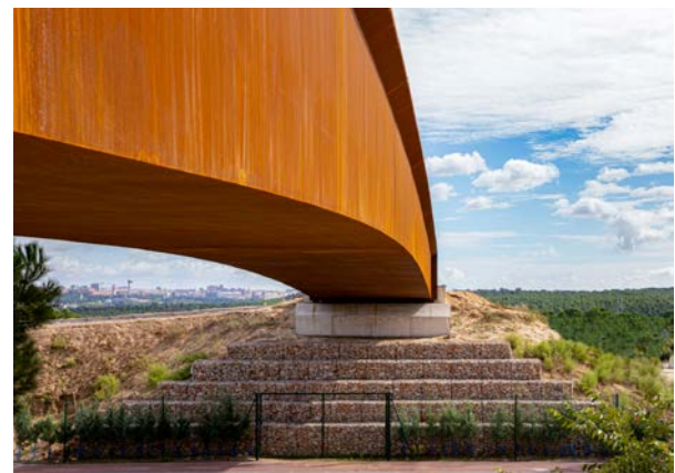
Figura 7 Estribo izquierdo sobre muros de gaviones.
