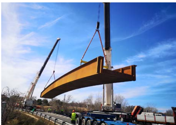
Figura 12 Montaje de la viga en posición.
