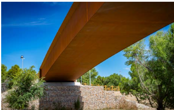
Figura 8 Estribo derecho sobre gaviones.
