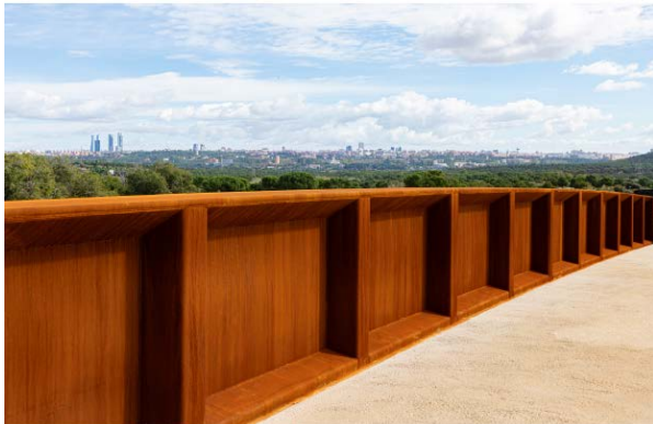
Figura 6 Alma de una de las vigas vista desde el interior de la pasarela.
