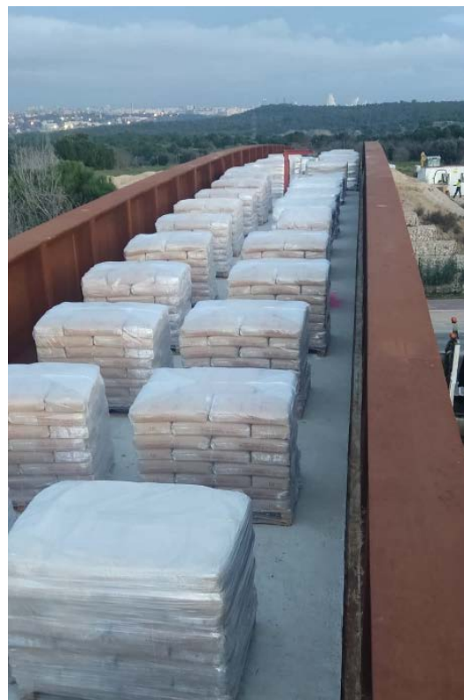
Figura 14 Prueba de carga de estructura.
