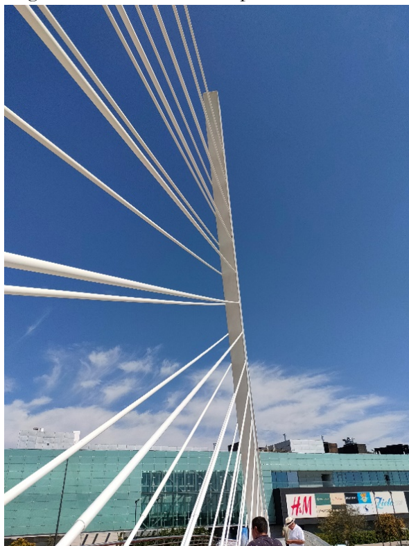
Figura 5 .- Vista frontal del pilono.
