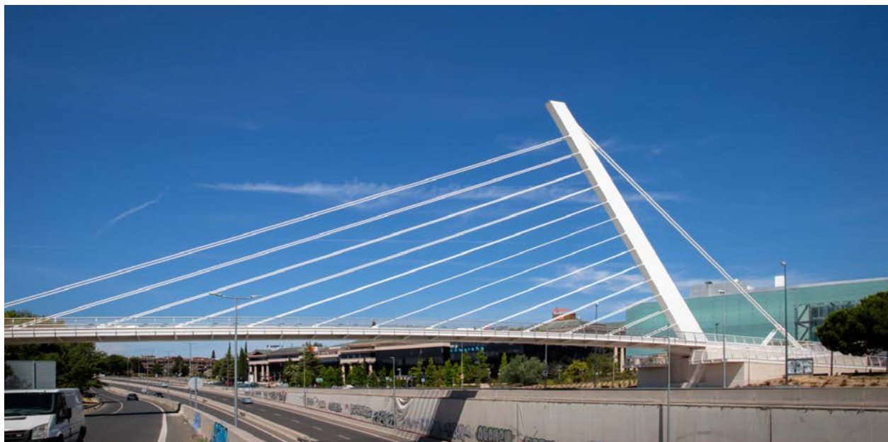
Figura 11. Vista de la pasarela finalizada
