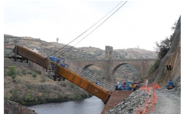
Figura 8. Avance en voladizo desde el lado derecho con el puente romano al fondo.
