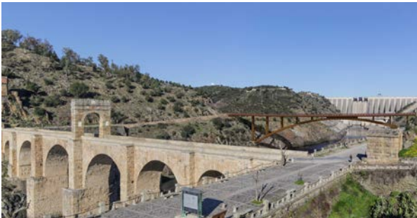
Figura 1 Puente Romano de Alcántara junto con el nuevo puente en segundo plano.
