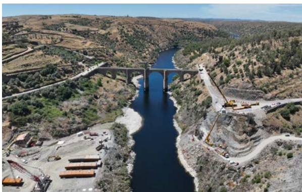
Figura 3 Vista de accesos y plataformas de trabajo durante la construcción.
