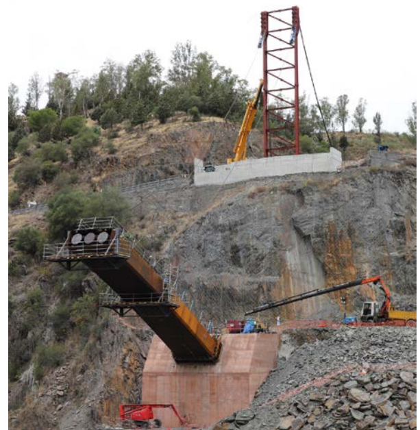
Figura 6 Arranque semiarco derecho con torre de atirantamiento sobre estribo.
