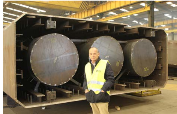
Figura 2. Sección metálica de arco en taller.
