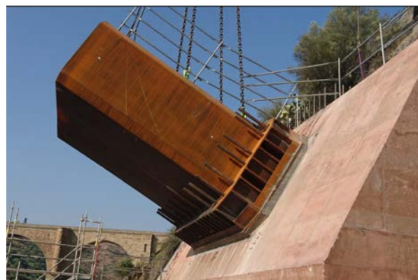
Figura 4. Arranque del arco cosido con barras de 75 mm al plinto derecho de hormigón tintado.
