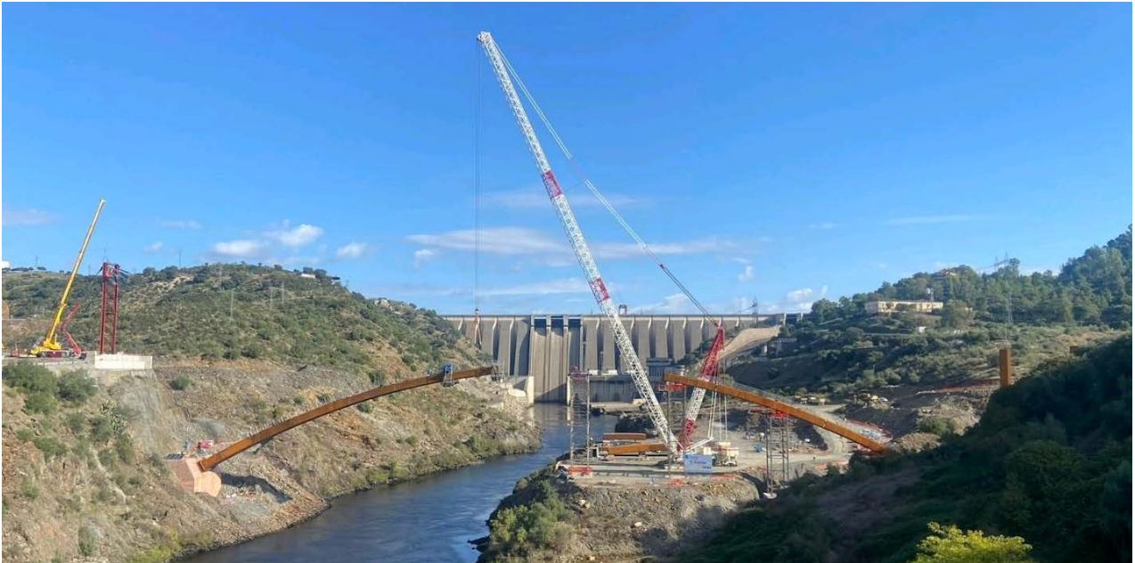
Figura 5. Vista del montaje de los dos semiarcos. El derecho por avance en voladizo y el semiarco izquierdo sobre pilas provisionales cimentadas sobre la plataforma de trabajo de la grúa.
