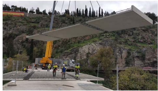
Figura 6. Montaje de prelosas prefabricadas de hormigón con la anchura definitiva del puente.
