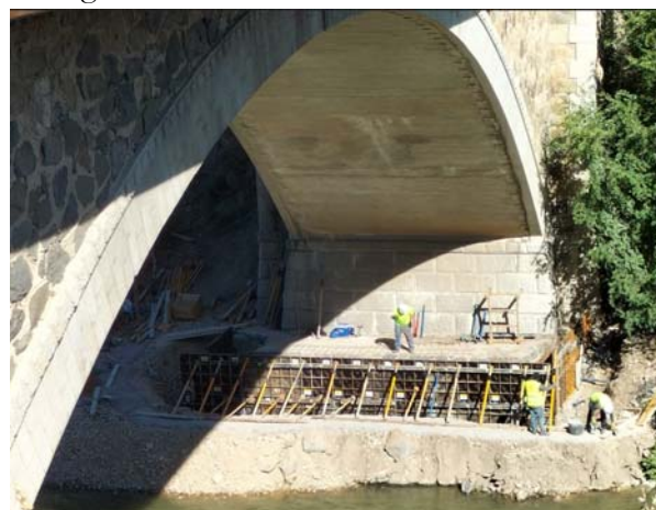
Figura 11. Ejecución de viga perimetral de defensa de las cimentaciones de margen izquierda.
