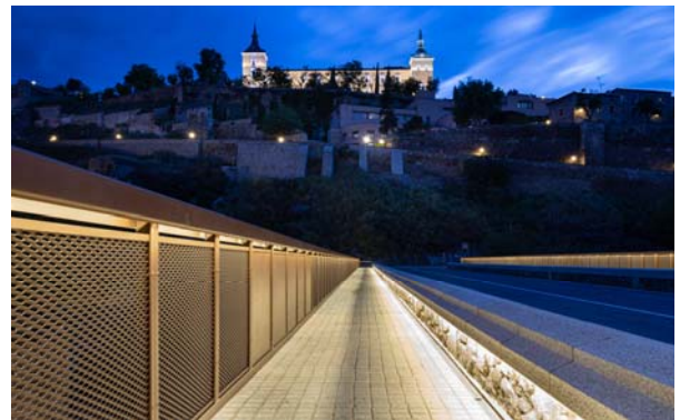
Figura 8. Acera iluminada con tira led integrada en barandilla y pretilos de mampostería.
