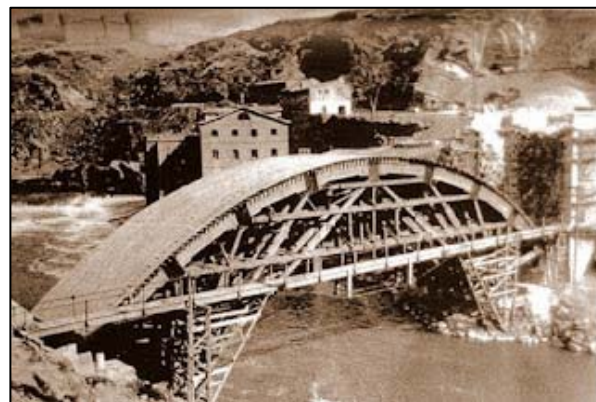
Figura 5. Cimbra de madera utilizada durante la construcción del arco de hormigón en masa.
