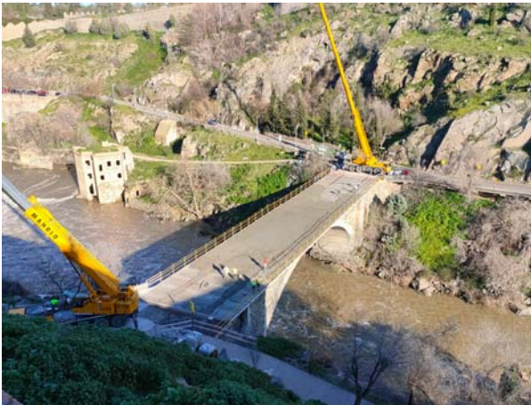
Figura 7. Hormigonado de la losa sobre prelosas con hormigón ligero autocompactante.
