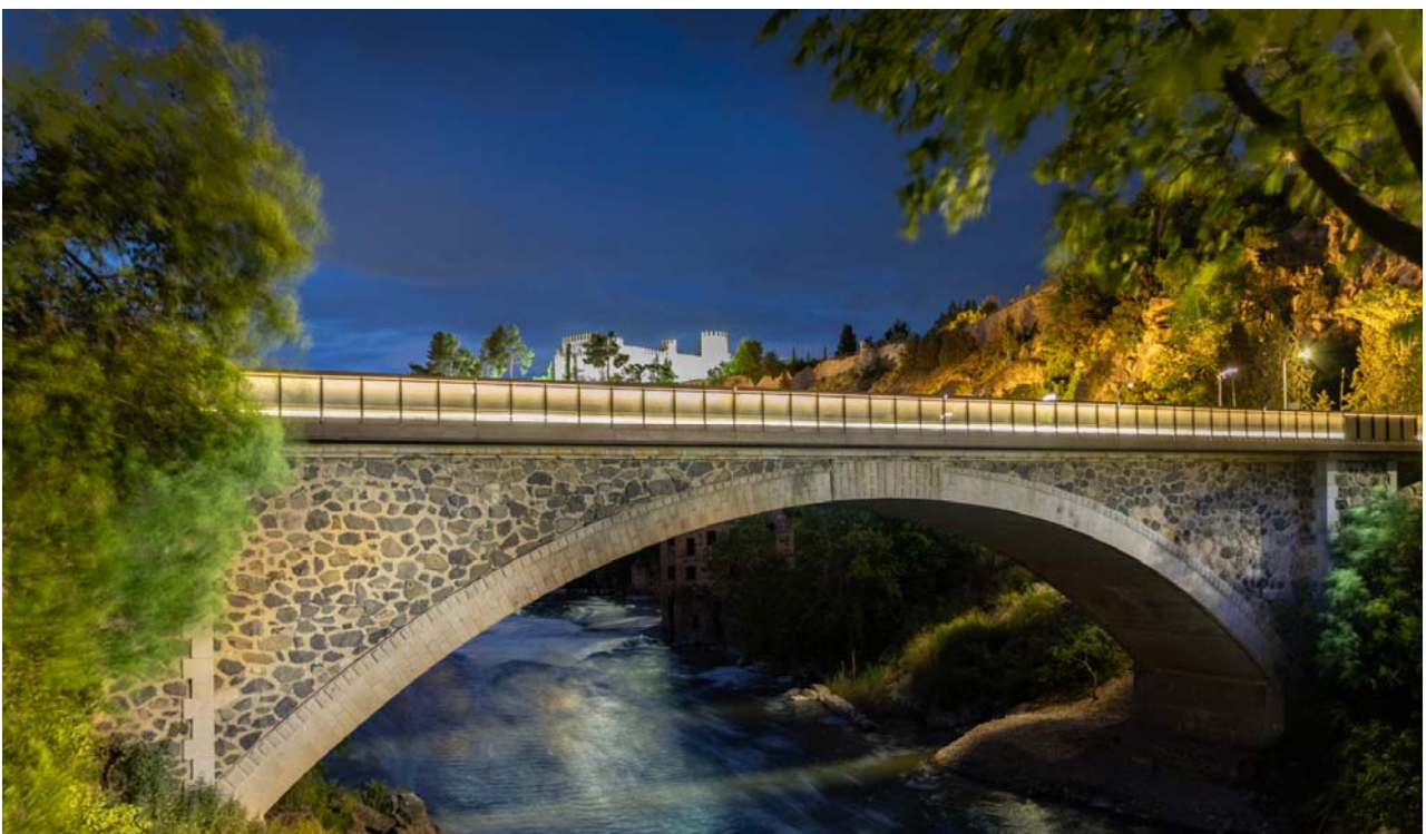
Figura 9. Aspecto final del puente, manteniendo la estética del puente original.
