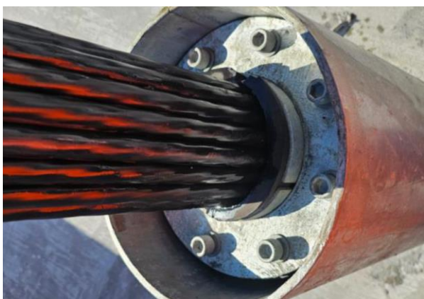
Figura 15. Instalación de desviador.
