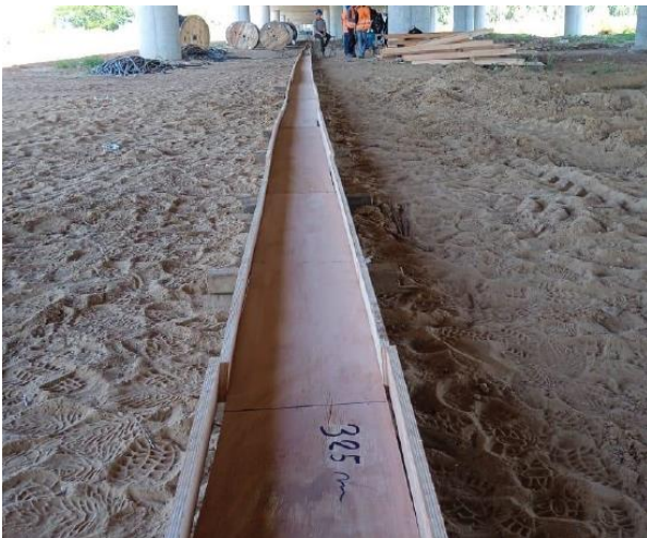
Figura 7. Pista de preparación de los cordones.
