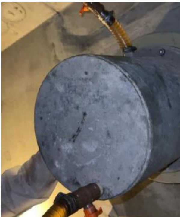
Figura 14. Inyección de anclaje.
