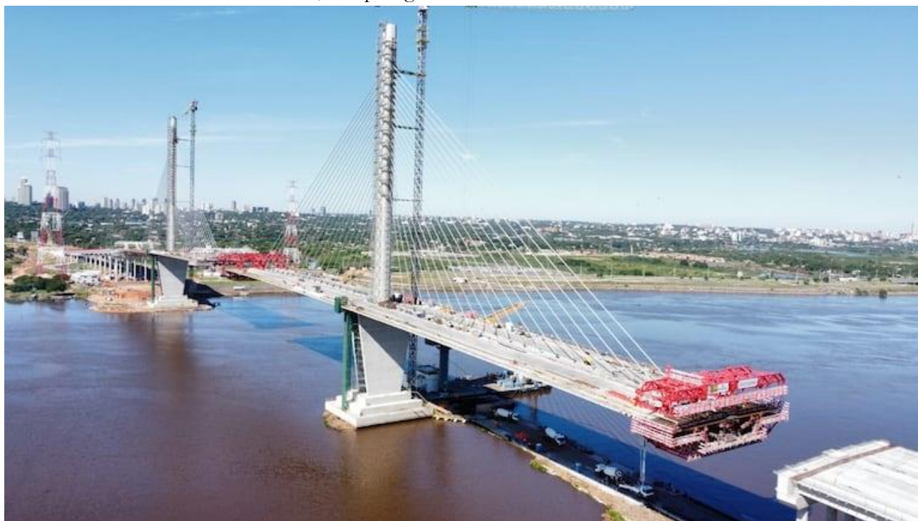
Figura 2. Vista aérea del puente atirantado durante construcción.
