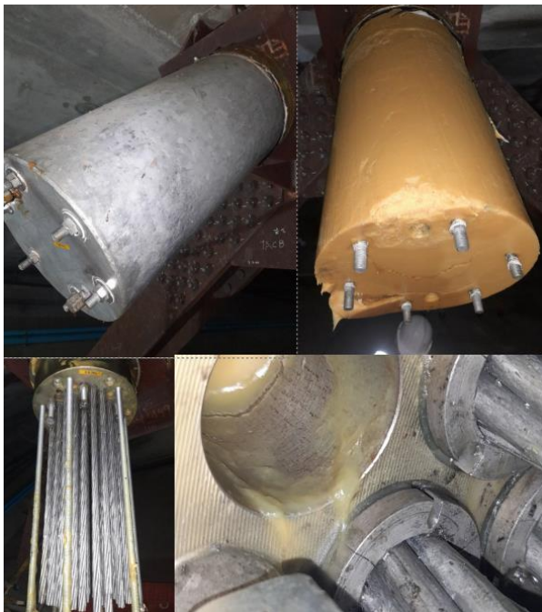
Figura 7. Puntos de inspección de los anclajes en el Puente Centenario. Fotografías de VSL
