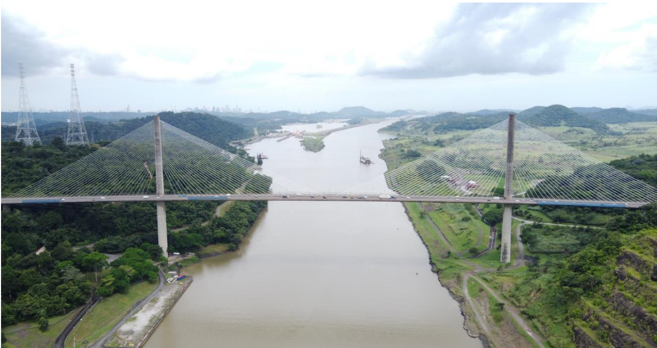
Figura 1. Puente Centenario. Fotografía de VSL
