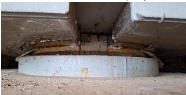
Figura 28. Apoyo POT en estribo 2.
