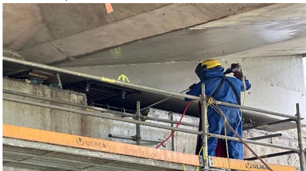
Figura 29. Hidrodemolición de hormigón de apoyos.
