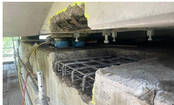
Figura 30. Zona de apoyos hidrodemolidada.
