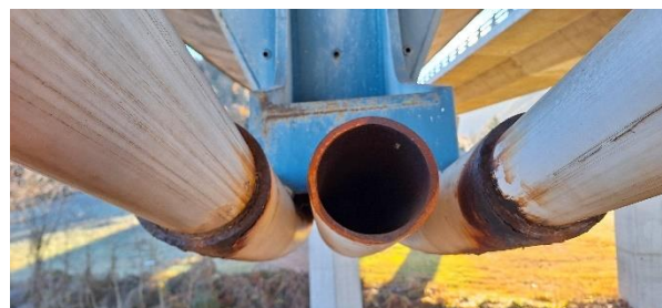
Figura 9. Tubo deflector de reserva en desviador.
