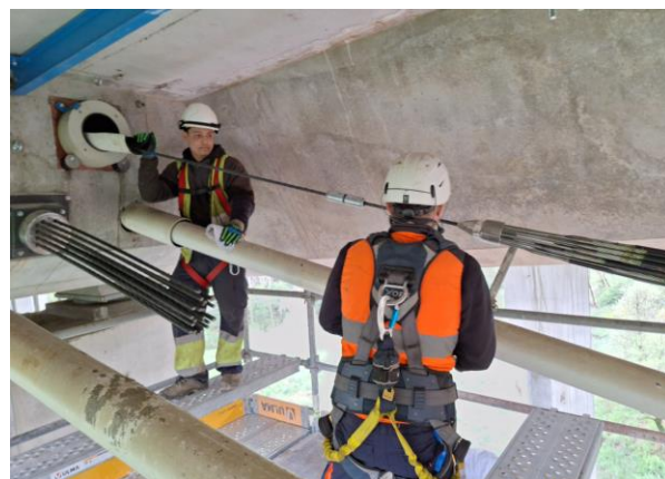
Figura 23. Enfilado de cordones.
