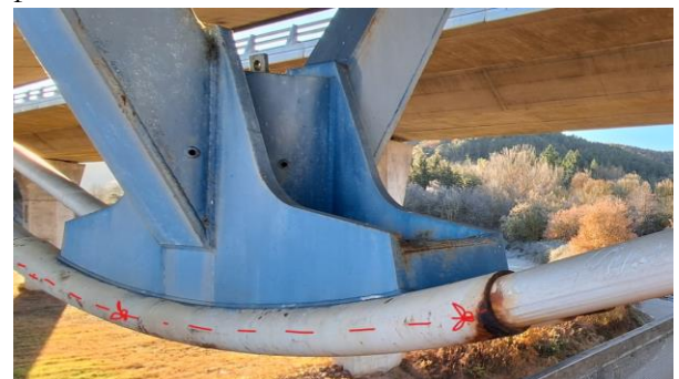
Figura 14. Línea de corte del tubo deflector.
