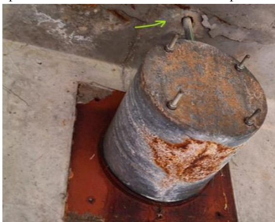
Figura 8. Oxidación del capot.
