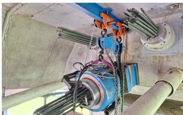
Figura 12. Tesado mediante gato multicordón.
