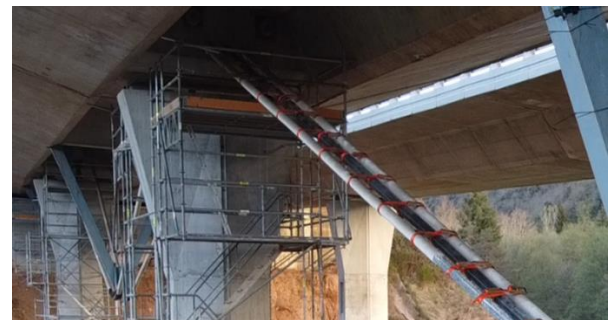
Figura 13. Arriostramiento de los tendones.
