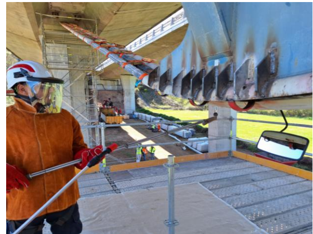
Figura 20. Proceso de corte tendón prototipo.
