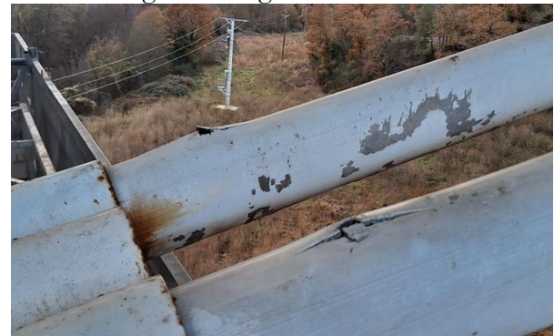
Figura 5. Orificio de inyección en vaina..
