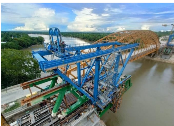
Figura 6. Pórtico de izaje en posición de izaje.
