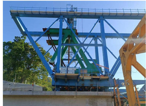
Figura 11. Posición de la viga transversal de izaje durante el lanzamiento del pórtico de izaje.
