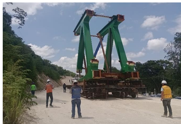
Figura 9. Movimiento de la dovela mediante el uso de bogies de tren.
