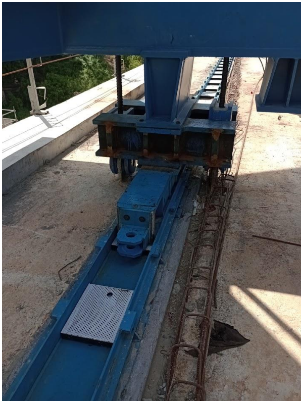
Figura 12. Sistema de lanzamiento del pórtico.
