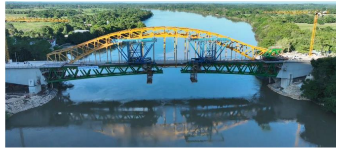
Figura 16. Vista longitudinal del nuevo puente de Boca del cerro durante su construcción.
