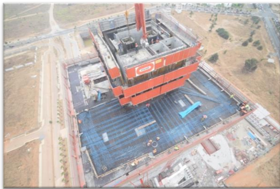
Figura 1. Vista aérea de estructura con núcleo trepado y solución de losa postesada.
