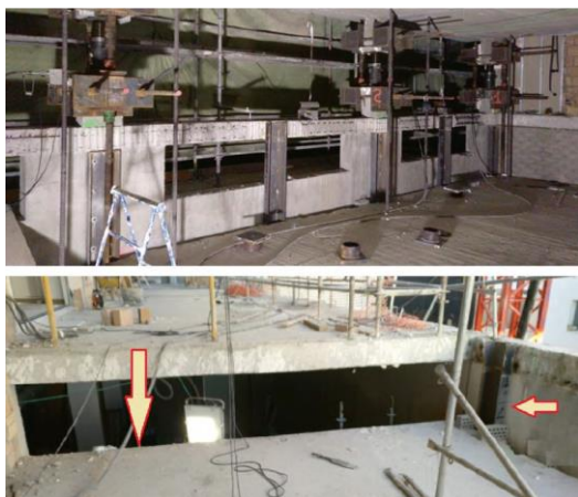
Figura 9 Estabilización y guiado aprovechando muros perimetrales “Palma”
