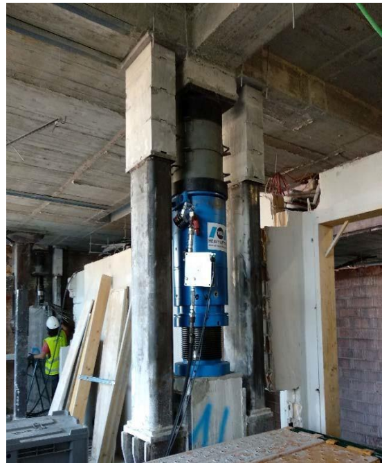
Figura 2 Sistema de soportes (bloques UHPC), gato y discos descenso “Barcelona”
