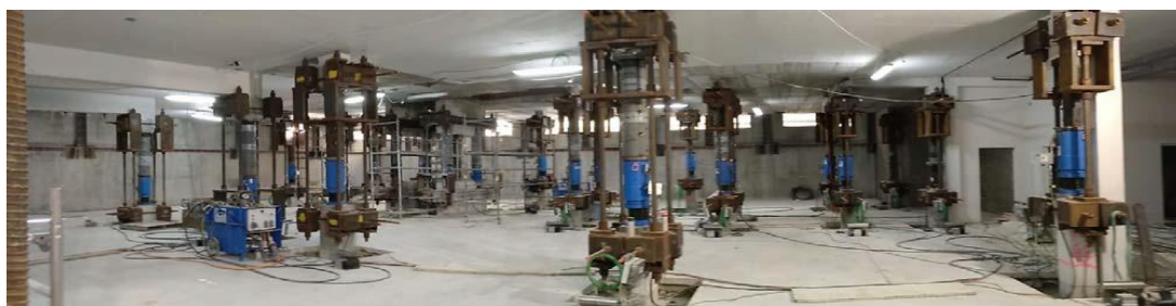
Figura 5 Vista general en “Palma” de parte de los puntos de gateo listos para inicio maniobra
