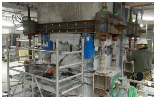
Figura 7 Detalle estructura puenteo núcleo “Palma”
