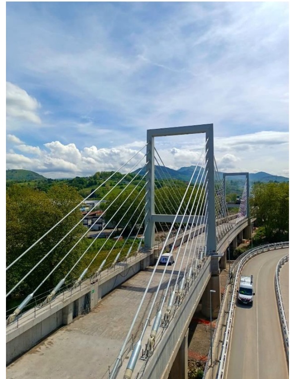
Figura 1. Vista aérea del viaducto atirantado.
