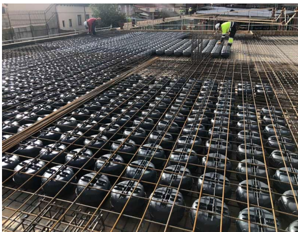
Figura 2. Losa aligerada biaxial “Unidome”.
