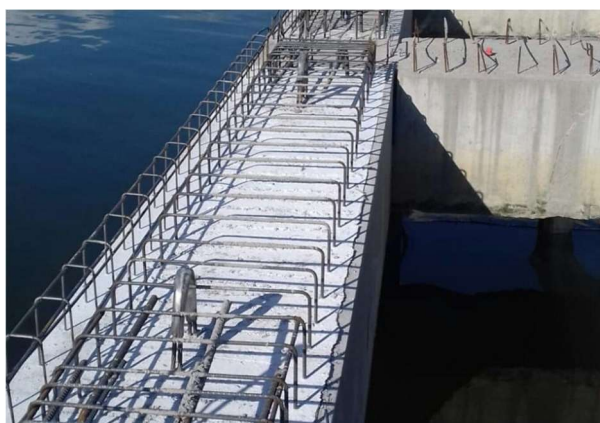
Figura 3. Vigas-cantil prefabricadas colocadas en obra. Detalle de armadura transversal en espera.
