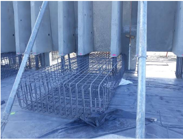
Figura 25. Ferralla de la zapata.
