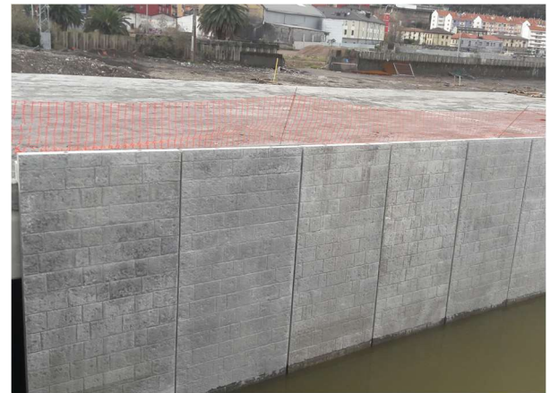
Figura 7. Acabado arquitectónico de tipo mampostería en cara vista de muros-faldón.
