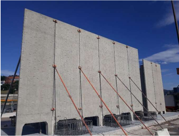
Figura 24. Paneles premontados en la solera del acopio.
