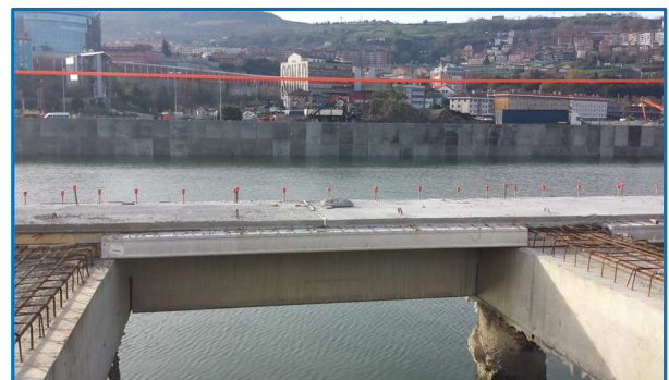
Figura 2. Alineaciones de pilotes y vigas-cantil en obra con losa de compresión parcialmente ejecutada.
