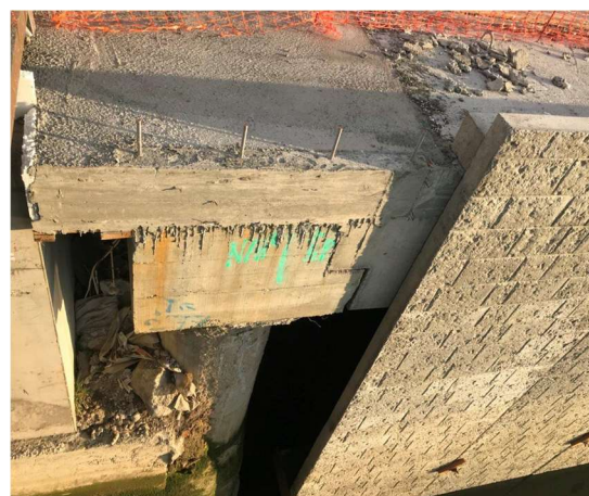
Figura 4. Muro-faldón colocado en obra. Detalle de esperas en peto de hormigón para apoyo del muro.
