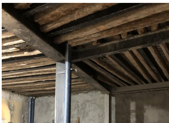
Figura 9. Disposición de viguetas metálicas y material de madera.
