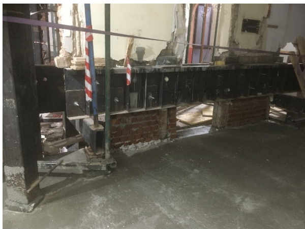
Figura 6. Detalle de pareja de UPN de Fase 2 del procedimiento de ejecución.
