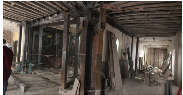
Figura 11. Diseño de doble viga y castilletes.
