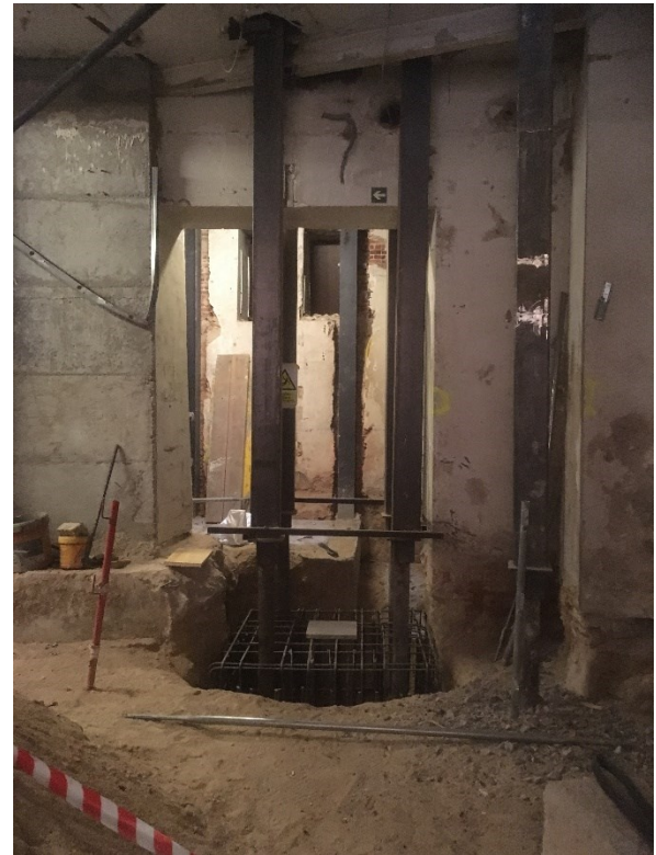
Figura 4. Encepados provisionales y micropilotes.
