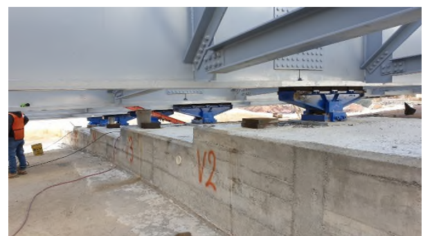
Figura 7. Puente en parque a la cota de lanzamiento.
