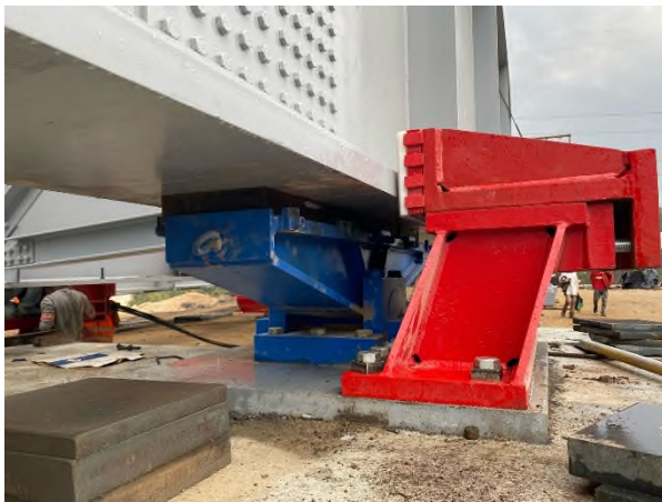
Figura 11. Apoyos provisionales y guías para el empuje.
