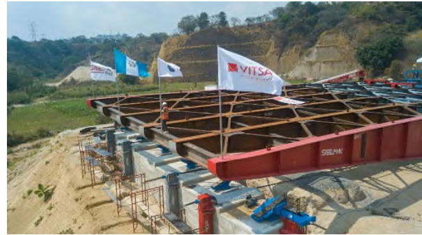
Figura 8. Vista del anclaje de tendones de empuje al estribo mediante ménsulas metálicas.
