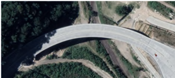
Figura 1. Vista en planta del puente. Fuente: Google Earth.
