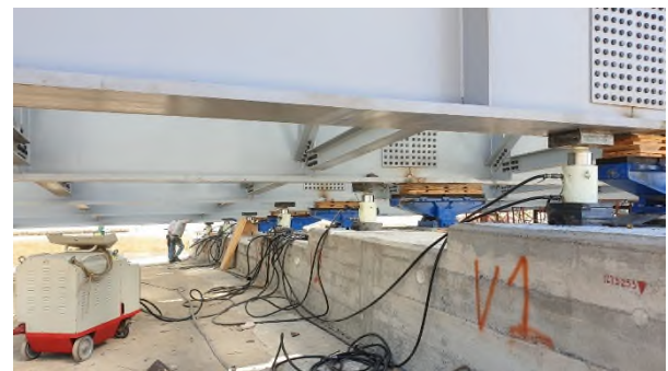
Figura 6. Montaje sobre apoyos provisionales en parque.
