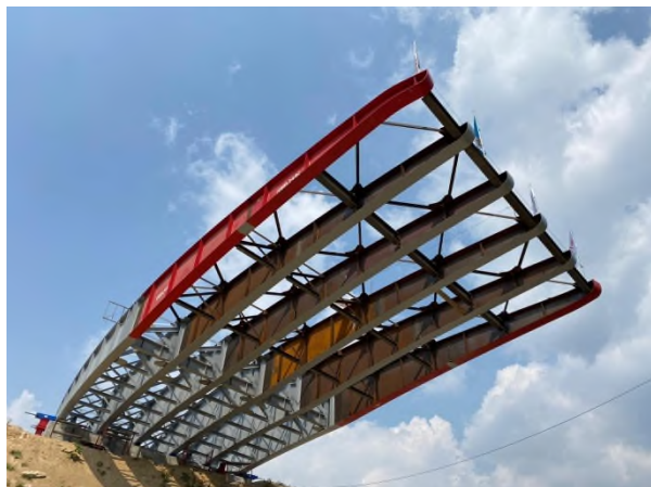
Figura 13. Vista de la primera fase de lanzamiento donde se aprecia la nariz de empuje.
