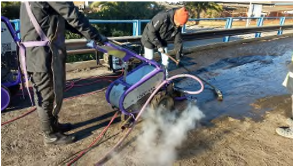
Figura 7. Retirada de impermeabilización existente.
