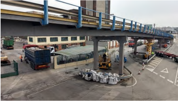
Figura 8. Decapado de tablero metálico.
