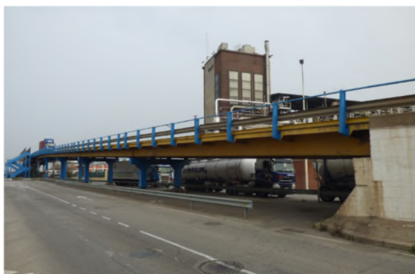
Figura 2. Vista general del puente previamente a las actuaciones. Acceso desde el lado mar.
