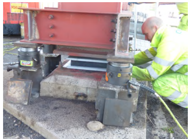
Figura 13. Levantamiento para sustitución de apoyos.
