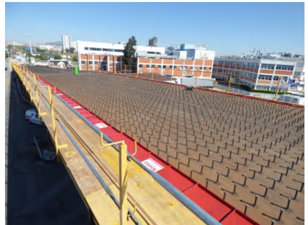
Figura 12. Instalación de pernos conectadores.
