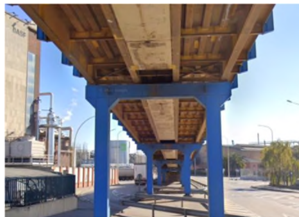
Figura 1. Vista de las pilas y el tablero.
