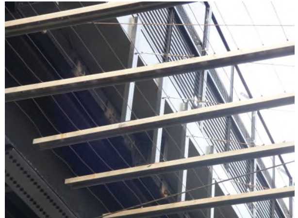
Figura 1. Modificación de ménsulas DCO.
