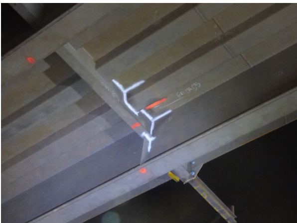
Figura 10. Reparación de soldaduras.
