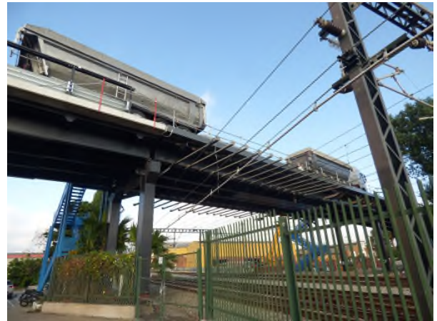
Figura 17. Prueba de carga
