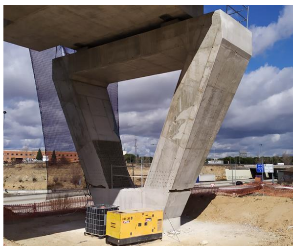
Figura 8. Aspecto general de la pila
