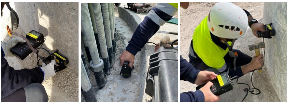
Figura 6. Realización de ensayos de Impacto-Eco
