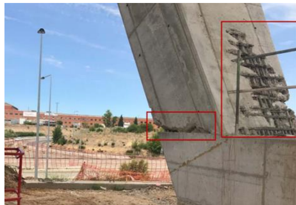
Figura 7. Estudio de integridad del hormigón de una pila de un viaducto mediante END.
