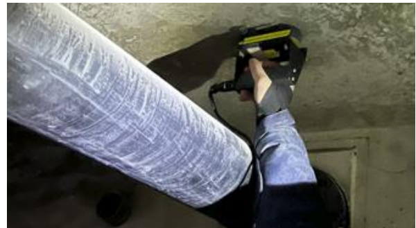
Figura 12. Realización de ensayo in situ
