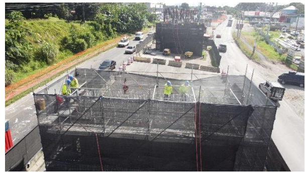
Figura 7. Ejecución de las pilas
