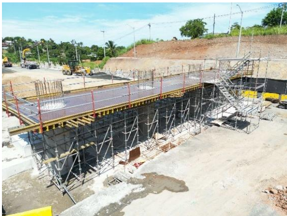
Figura 9. Cimbra cuajada en estribo
