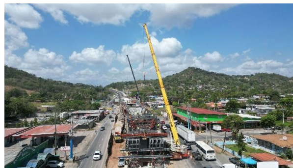
Figura 10. Vista delantera cimbrado
