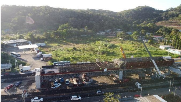
Figura 11. Configuración de cimbra porticada
