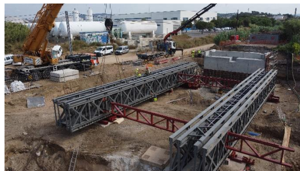
Figura 14. Baterías de la cimbra durante el montaje de la fase 1
