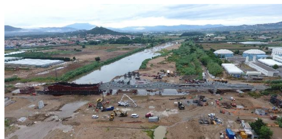
Figura 11. Fase 4 de ejecución del tablero
