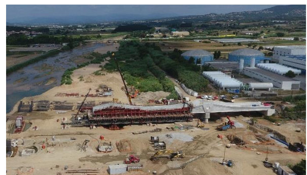
Figura 9. Fase 2 de ejecución del tablero
