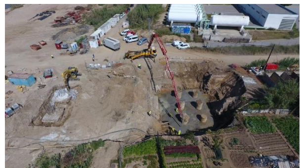
Figura 4. Pilotes de estribo E2 y pila P1.
