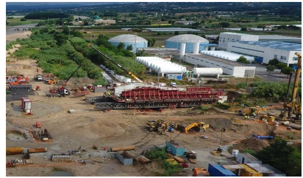
Figura 8. Fase 1 de ejecución del tablero
