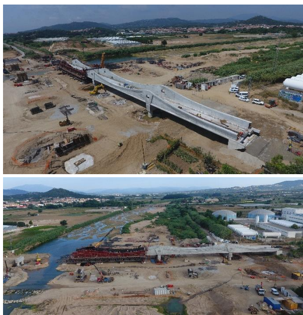
Figura 10. Fase 3 de ejecución del tablero
