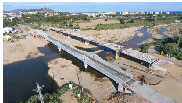
Figura 2. Nuevo puente ferroviario junto al puente carretero en construcción.
