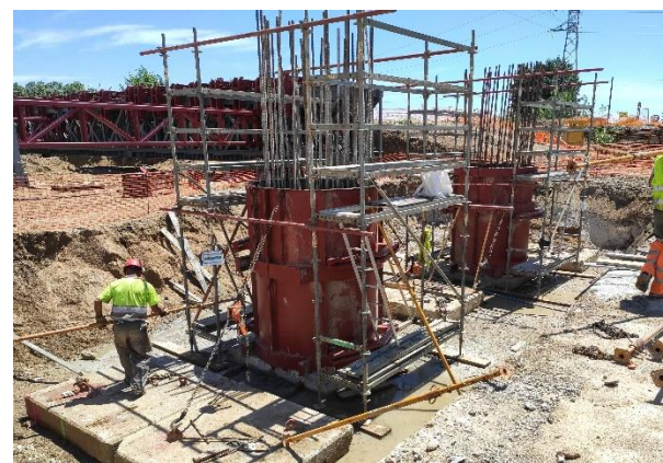
Figura 6. Construcción de las pilas
