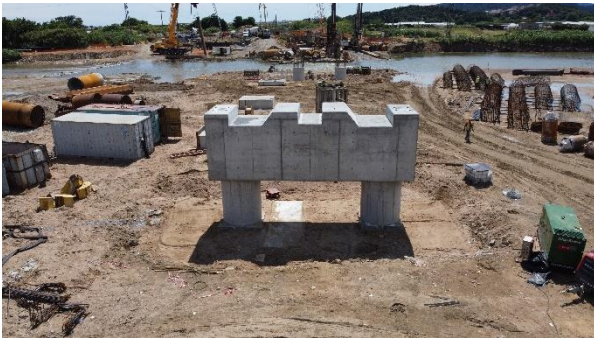
Figura 7. Dintel de hormigón
