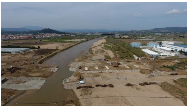
Figura 3. Plataformas de trabajo y cimentaciones existentes.
