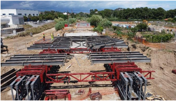
Figura 16. Montaje de vigas de fondo y vigas de apoyo sobre las baterías
