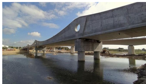
Figura 21. El puente finalizado
