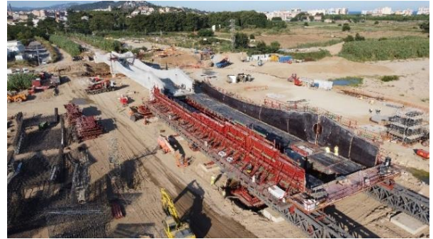
Figura 19. Montaje de encofrados en fase 3
