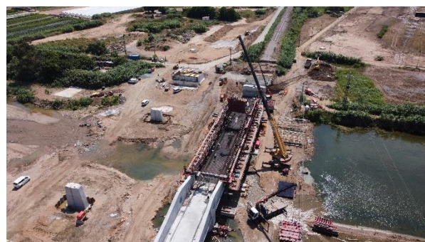
Figura 12. Fase 5 de ejecución del tablero
