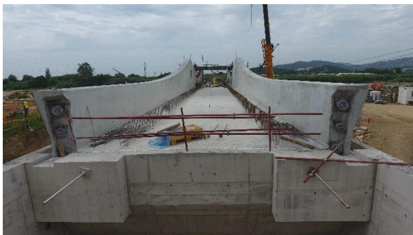
Figura 13. Vista del tablero desde el estribo E2 con anclaje provisional
