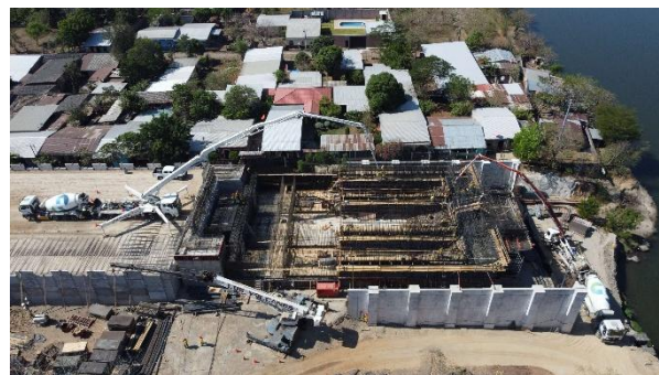
Figura 16. Ejecución del vano lateral
