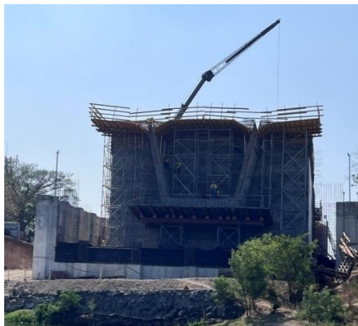
Figura 17. Ejecución de la dovela 0.
