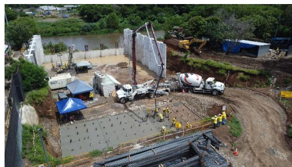
Figura 10. Ejecución de micropilotes en estribo 1.
