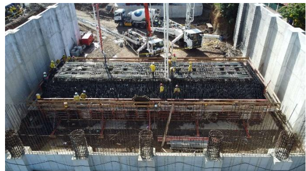
Figura 12. Hormigonado del pedestal.
