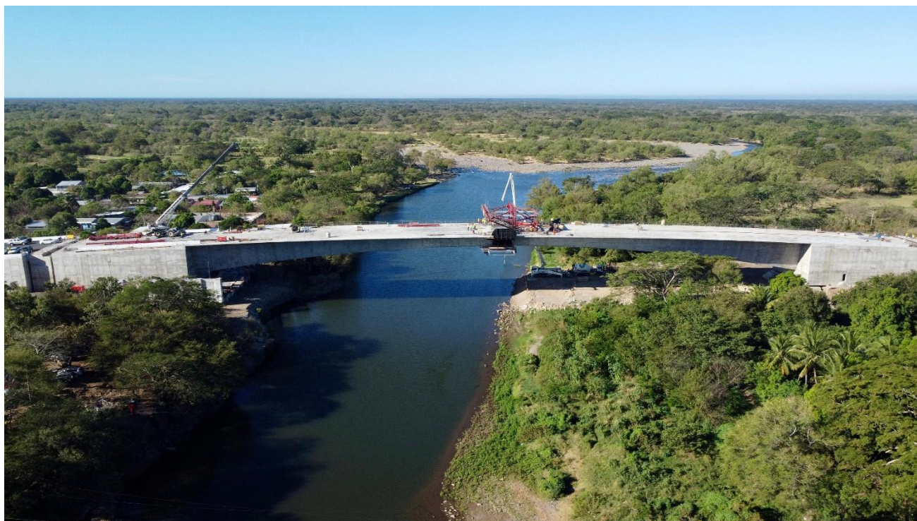
Figura 22. Hormigonado de la dovela de cierre.
