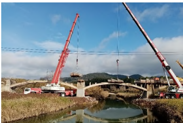
Figura 11. Vista del desmontaje de piezas de cubierta cortadas.
