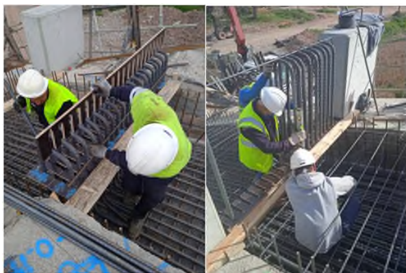
Figura 12. Colocación de las barras de espera de uno de los montantes.
