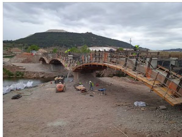
Figura 13. Enfofrado del nuevo arco colgado de los arcos originales.
