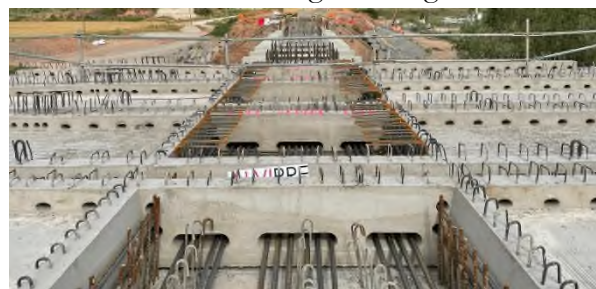
Figura 14. Vista de losas prefabricadas con armadura inferior longitudinal de tablero atravesada y uniones inox.
