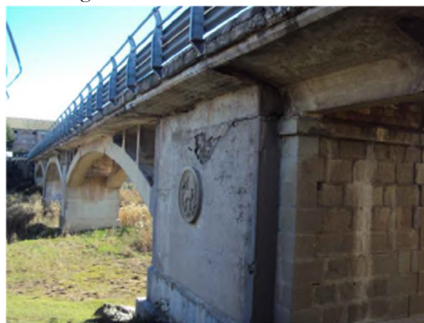
Figura 1. Fotografía del puente existente.
