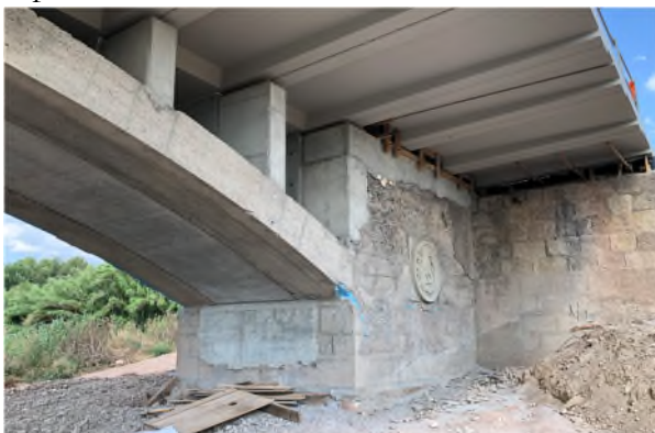
Figura 8. Imagen de arco, montantes y prelosas.
