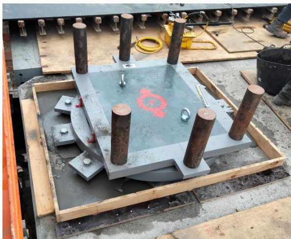
Figura 1. Ejemplo de un apoyo estructural.
