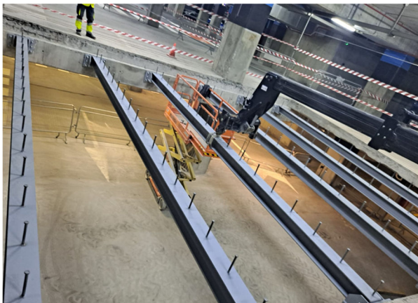
Figura 15. Instalación de vigas metálicas
