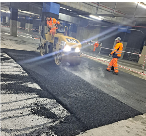
Figura 21. Extensión de mezcla bituminosa final de 3 cm de espesor
