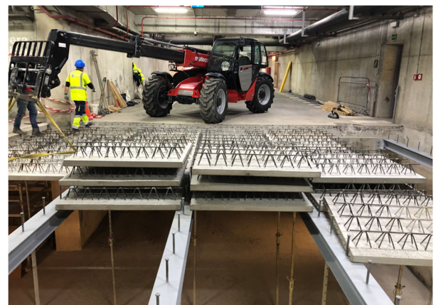
Figura 18. Detalle de instalación de prelasas con punto de acopio intermedio
