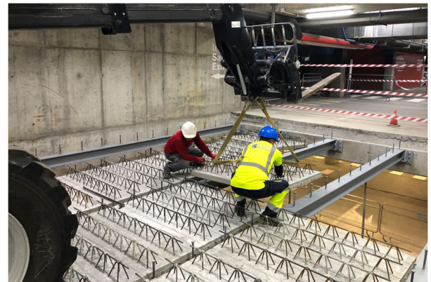
Figura 17. Detalle de instalación de prelasas
