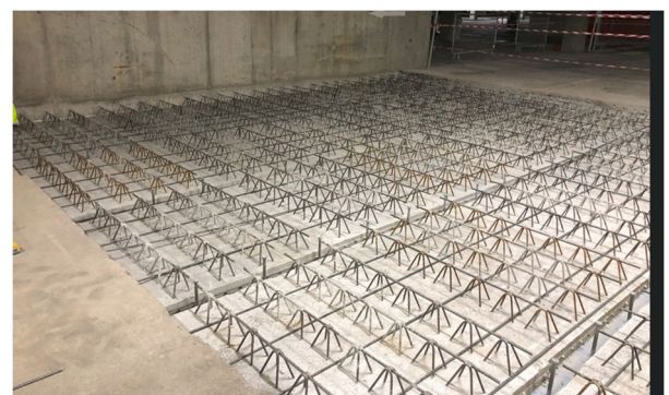
Figura 19. Aspecto del forjado tras la instalación de las prelasas
