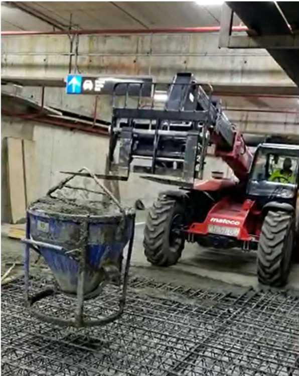
Figura 20. Hormigonado de losa con cubilote
