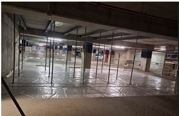
Figura 16. Detalle de instalación de apuntalamiento inferior bajo vigas metálicas
