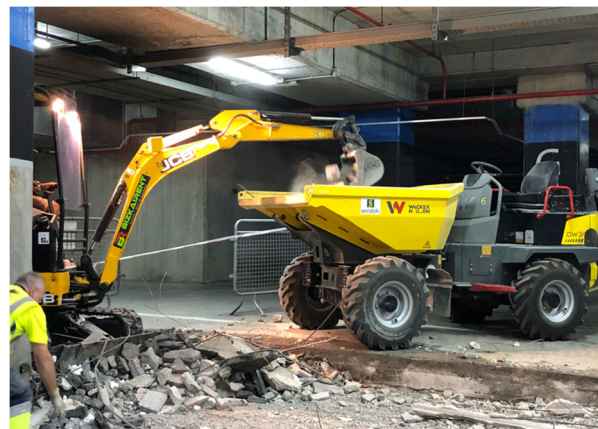
Figura 13. Detalle de evacuación de RCD mediante maquinaria auxiliar de pequeño tamaño y gálibo reducido
