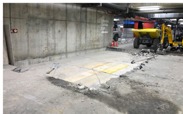
Figura 12. Demolición de forjado dañado
