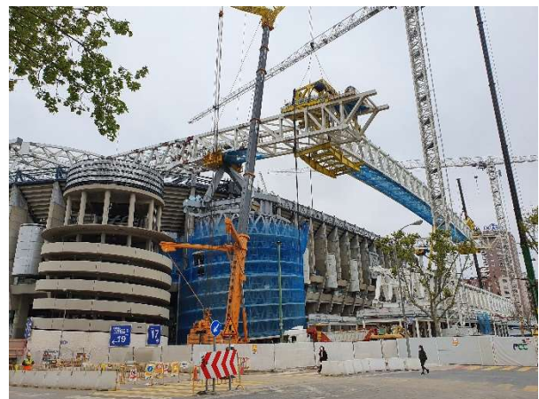
Figura 6. Conexión con el carro de traslación de una cercha secundaria en la Torre C.
