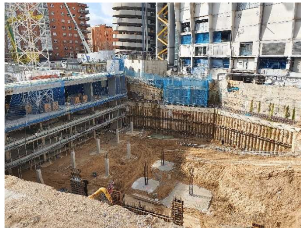
Figura 17. Vista de la ejecución de la fase 2 del aparcamiento.
