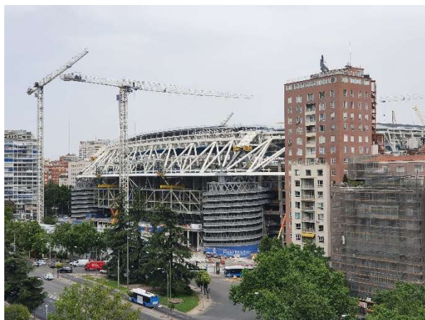
Figura 9. Vista general de la corona en el momento del izado del edificio museo. Lateral oeste en el paseo de La Castellana.
