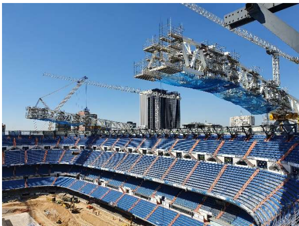
Figura 5. Cerchas atirantadas. Proceso constructivo mediante voladizos sucesivos. Lateral oeste
