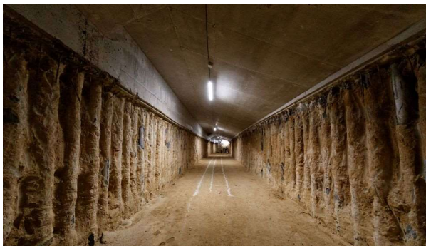
Figura 11. Vista de un tramo de la galería perimetral con los micropilotes aun visibles.
