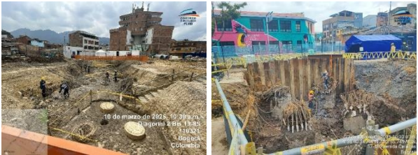
Figura 18. Pilotes PHC (izq) y preexcavados (der)
