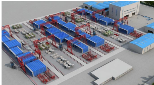
Figura 20. Disposición del patio de prefabricados de “Vigas U”.
