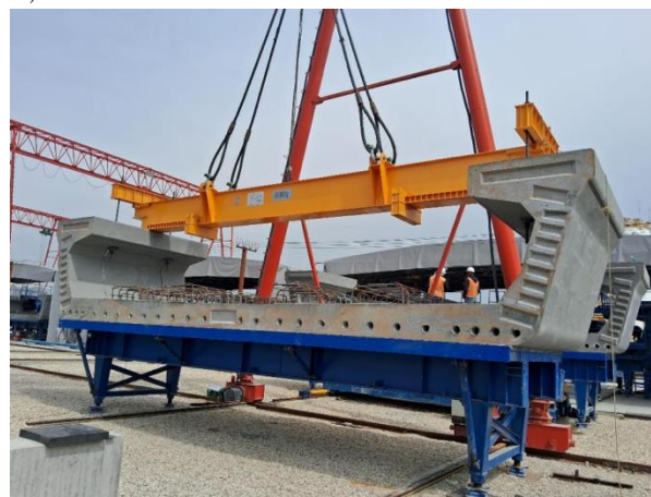
Figura 21. Dispositivo de izado de una dovela de la “Viga U”.
