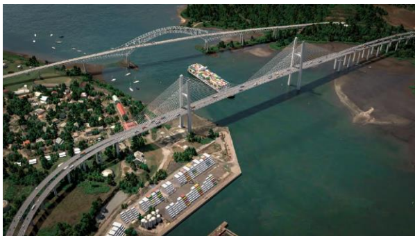
Figura 1. Montaje desde el lado Este del futuro puente atirantado. Puente de las Américas al fondo.
