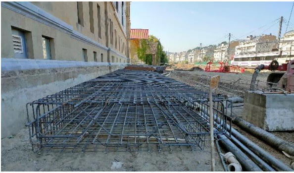
Figura 16. Foto de panel de armadura fabricada en taller.
