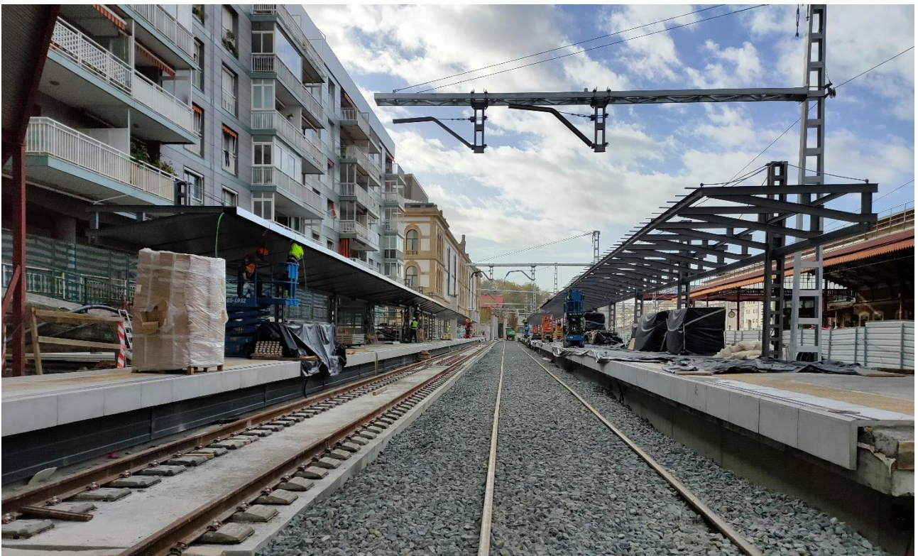
Figura 23. Foto de la losa de andenes días antes de la apertura.
