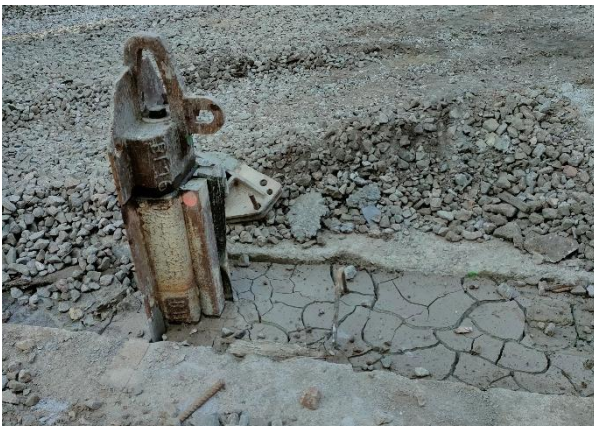
Figura 17. Foto de junta metálica trapezoidal con wáter-stop incluida.
