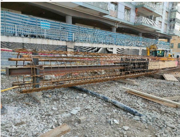
Figura 18. Foto de pila-pilote premontada para introducción en perforación.
