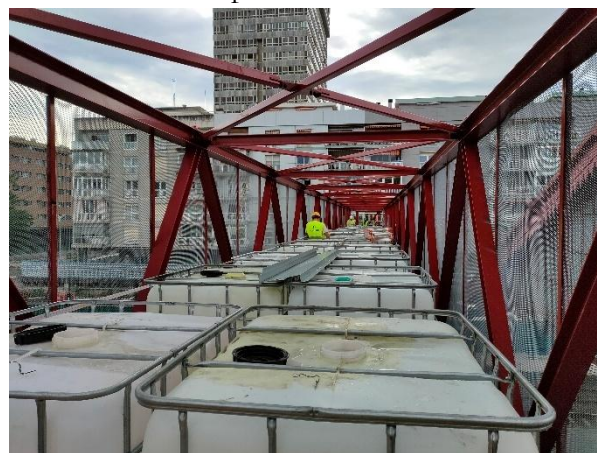
Figura 28. Foto de bidones de agua durante prueba de carga estática de pasarela provisional.
