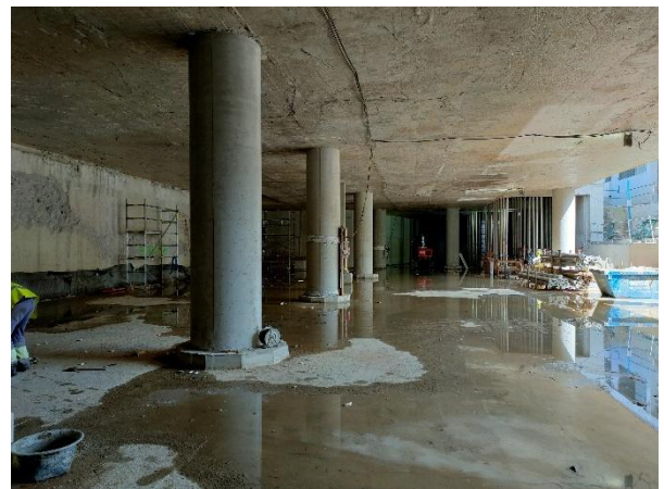
Figura 20. Foto de finalización de la excavación en mina con vista de las pilas-pilote revestidas por pilar definitivo.
