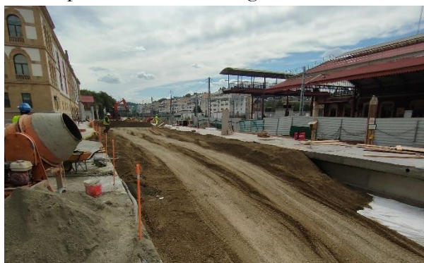
Figura 26. Foto de la bancada de tierra para prueba de carga estática.
