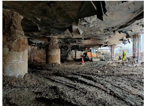
Figura 19. Foto de comienzo de la excavación en mina con vista de las pilas-pilote.
