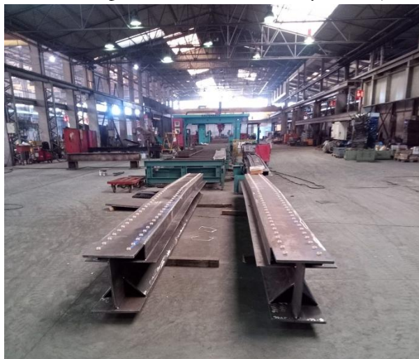
Figura 18. Foto de vigas transversales preparadas para la soldadura de conectores.
