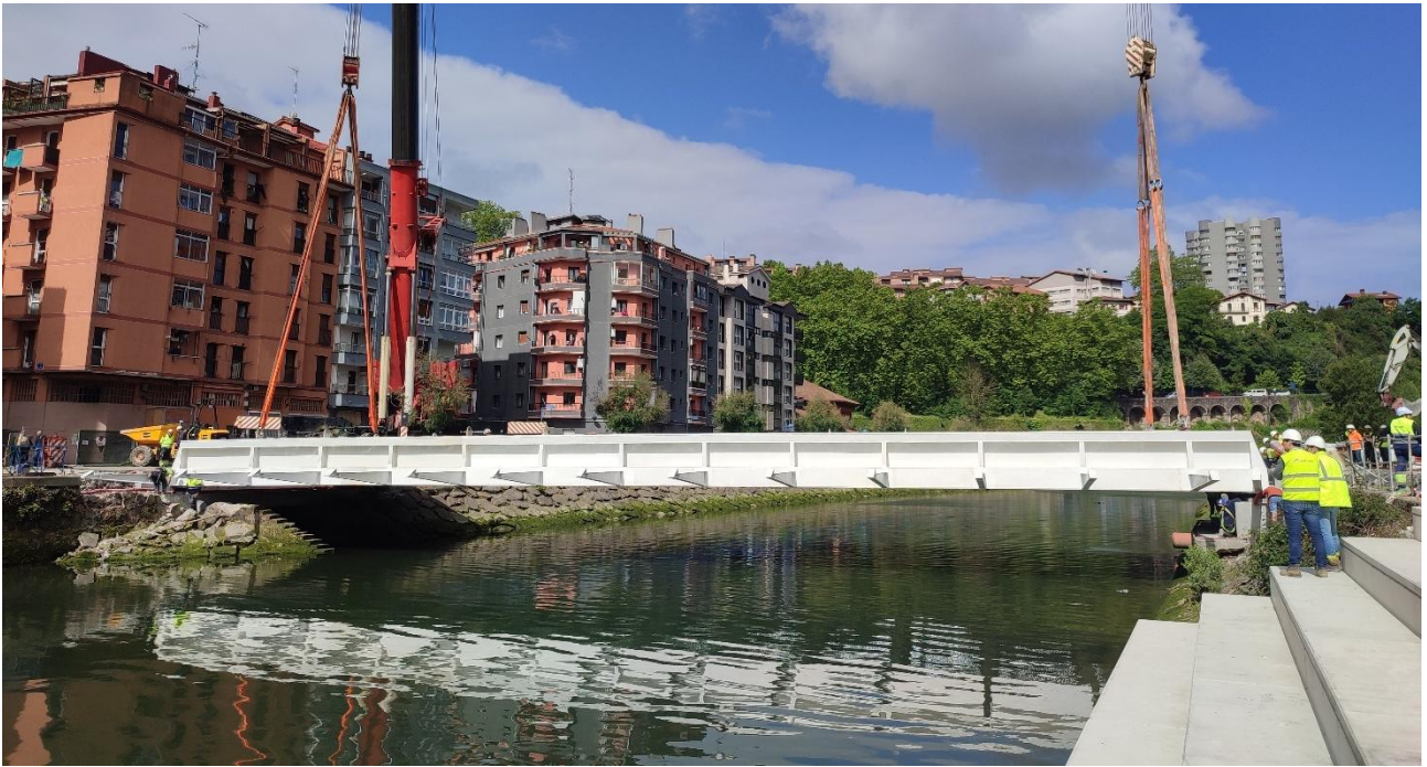
Figura 22. Foto del posicionamiento del tablero en su posición definitiva mediante las dos grúas.
