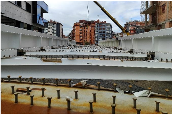
Figura 20. Fotos de montaje de tablero sobre bancadas.
