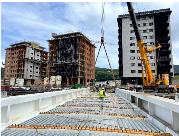
Figura 23. Foto de la zona central del tablero una vez instalado.
