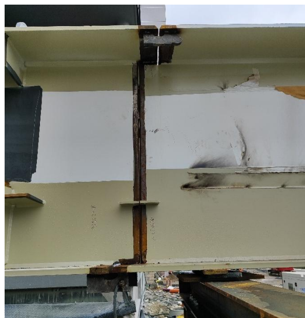
Figura 19. Foto de preparación de soldadura para conformación de viga principal completa.
