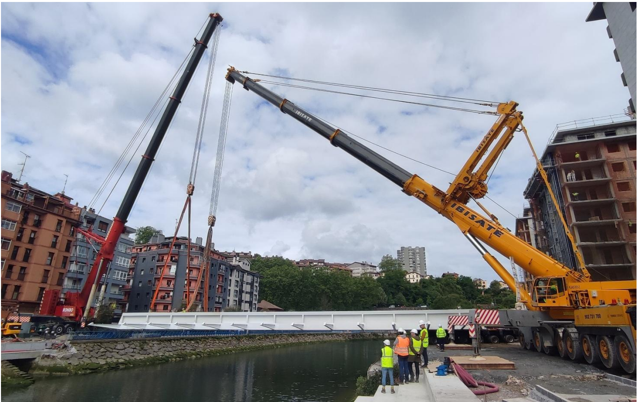
Figura 21. Foto del lanzamiento del tablero con la grúa de la margen derecha y fijación con la grúa de la margen izquierda.
