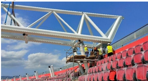
Figura 19. Foto de izado y colocación de primera cercha.
