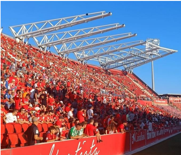
Figura 23. Foto durante partido de liga con montaje parcial de cubierta.
