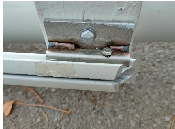
Figura 26. Foto de fijación regulable de perfil de aluminio.
