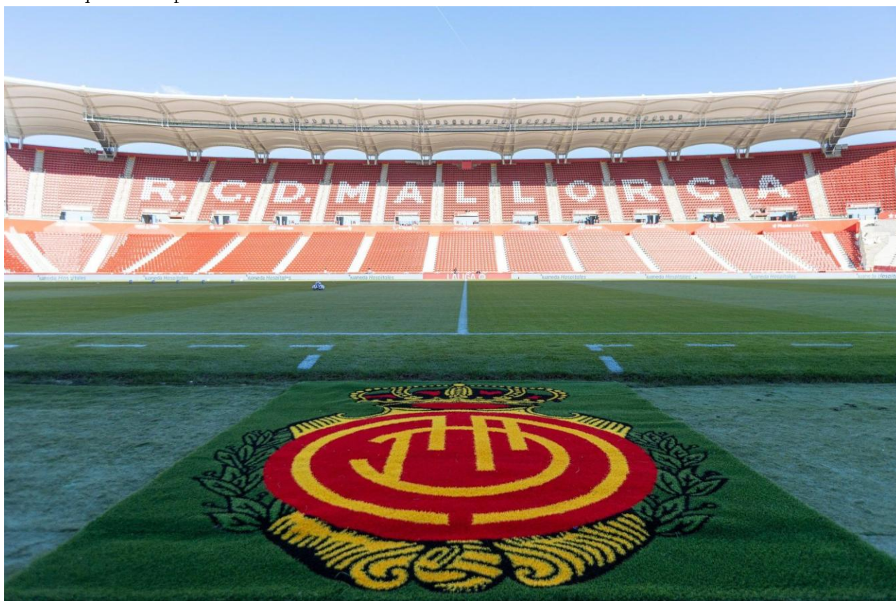
Figura 28. Foto desde el cesp  de cubierta terminada.
