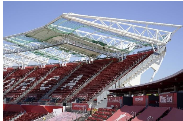
Figura 25. Foto de fase inicial de montaje membrana.
