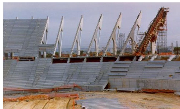
Figura 13. Foto del encofrado y hormigonado de pórticos de la tribuna Sol.
