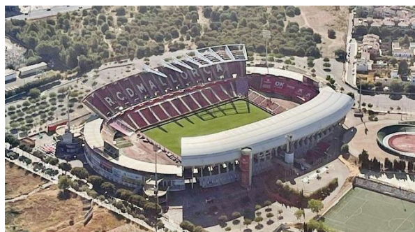
Figura 22. Foto desde helicóptero del avance del montaje de la estructura metálica de cubierta.
