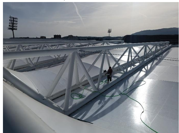
Figura 27. Foto de proceso de inundación de cubierta
