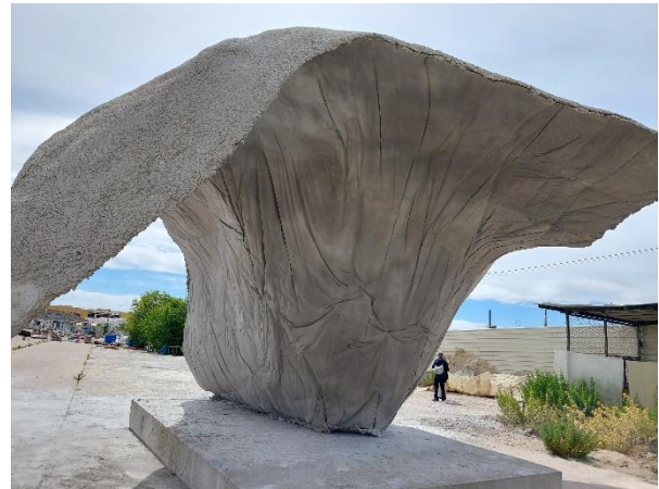
Figura 10. Prototipo de cubierta ejecutado previamente al inicio de la construcción del edificio. Texturas en el intradós del edificio The Cloud.
