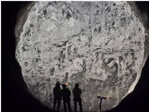
Figura 8. Sección de roca congelada. Imagen: Region Stockholm.
