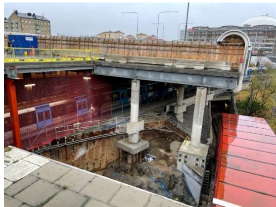
Figura 20. Hueco del pozo con el tráfico ferroviario. Imagen: Region Stockholm.
