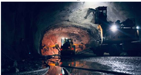
Figura 3. Ejecución de los túneles. Imagen: Region Stockholm.
