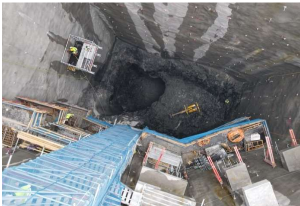
Figura 18. Vista en planta de la excavación del pozo de Gullmarsplan. Imagen: Region Stockholm.
