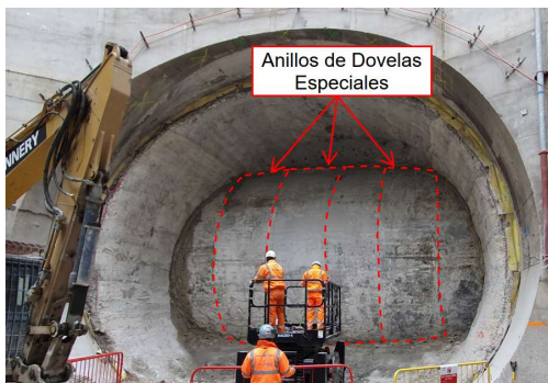
Figura 9. Anillos de dovelas especiales expuestos.
